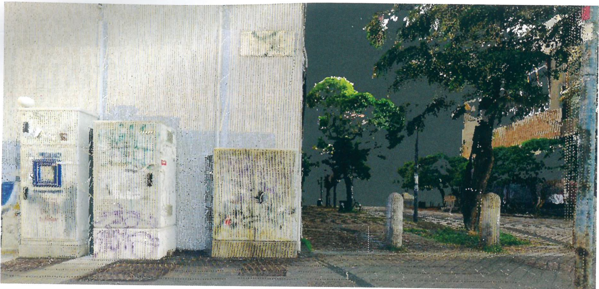
Fig.2: Particolare della nuvola di punti che mette in evidenza come siano leggibili le emergenze dei sottoservizi. Non è una fotografia ma un insieme dei punti rilevati opportunamente associati all'informazione di colore
