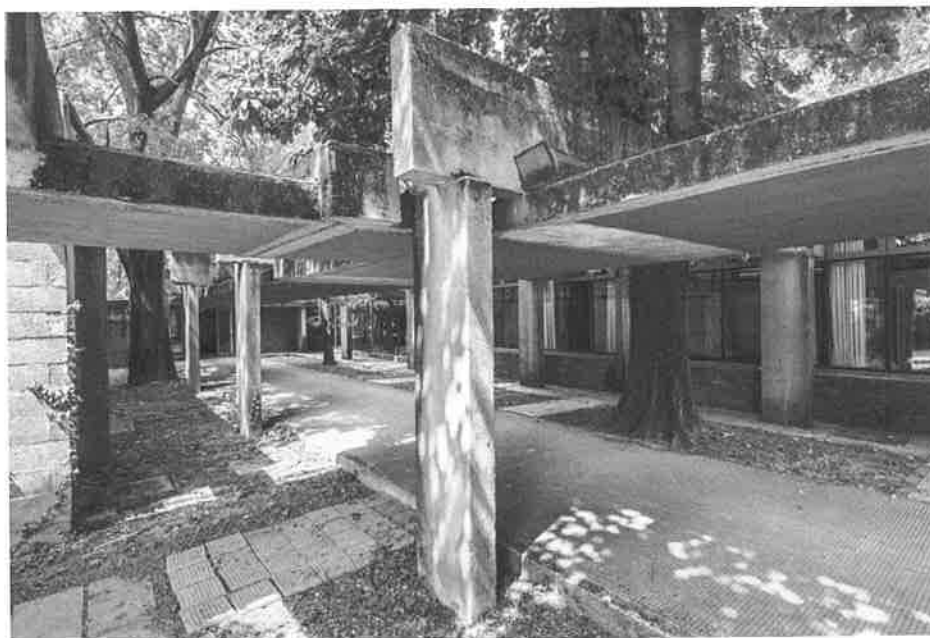
■ Slika 5. Istituto Marchiondi Spagliardi, Baggio, Milano, 1953. – 1957. Vittoriano Viganò, Silvano Zorzi. Foto Federico Padovani
