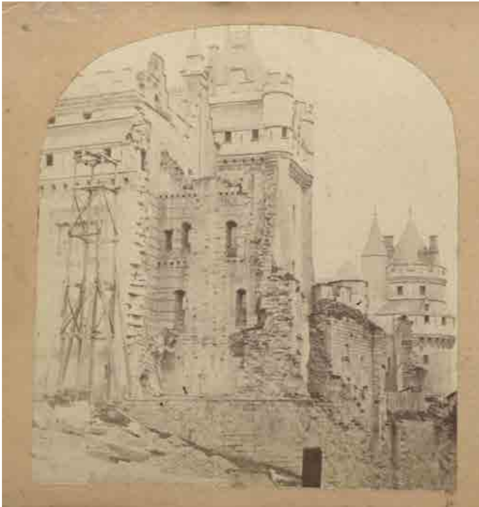
Figura 14. Pierrefonds, il castello durante i lavori di restauro in una foto del 1860 (Collezione E. Bentivoglio).
