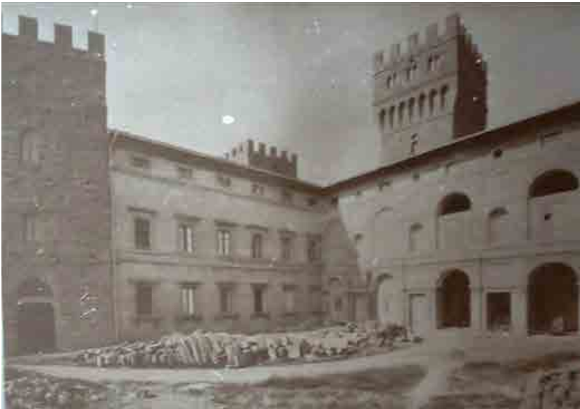
Figura 15. Torre Alfina, il cortile rinascimentale del castello appena concluso l'intervento di demolizione del corpo di fabbrica che lo ingombrava operato da Partini, in una fotografia dei fratelli Alinari (da Fratelli Alinari 1892).
