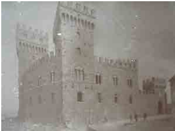
Figura 11. Torre Alfina, l'ala e la torre aggiunte da Partini nel lato d'ingresso del castello in una fotografia dei fratelli Alinari scattata alla fine dei lavori (da Fratelli Alinari 1892).
