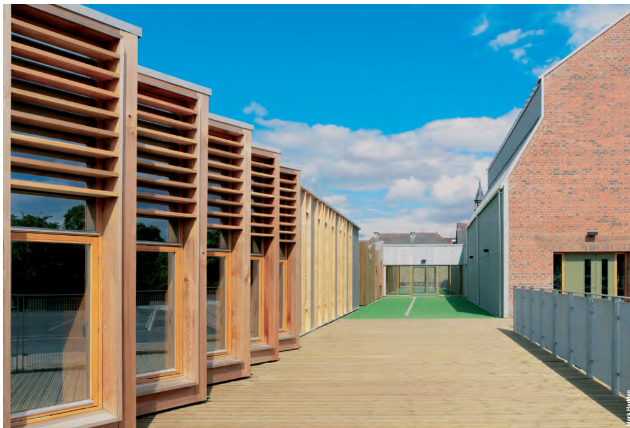
< La strada interna con il volume della sala polifunzionale e, a sinistra, il corpo della biblioteca e dell'aula informatica
