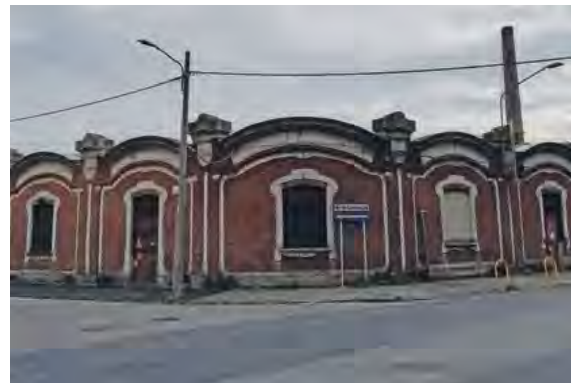
Il muro di cinta dell'ex cotonificio Maino identifica l'isolato storico e qualifica i fronti stradali. (Fotografia di Giovanna Fossa)
