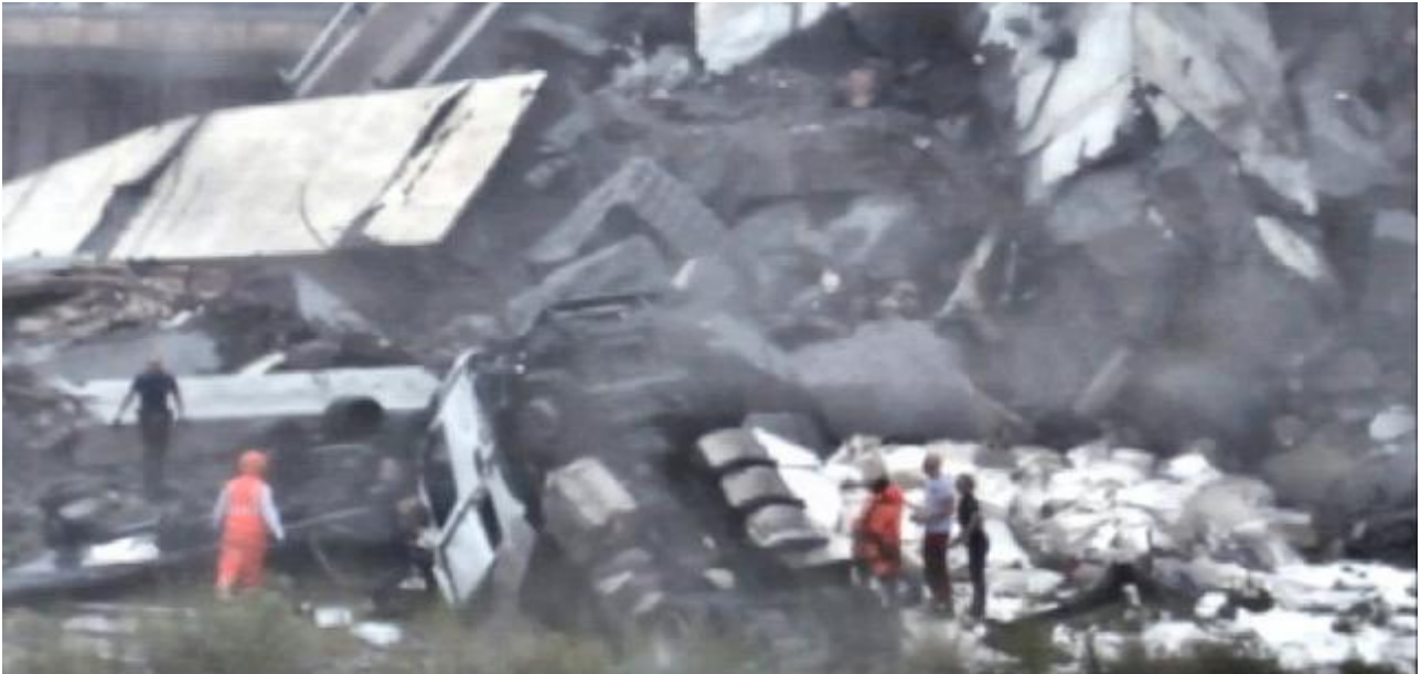
Figura 11. Le tracteur de la citerne entre les débris du pont.
