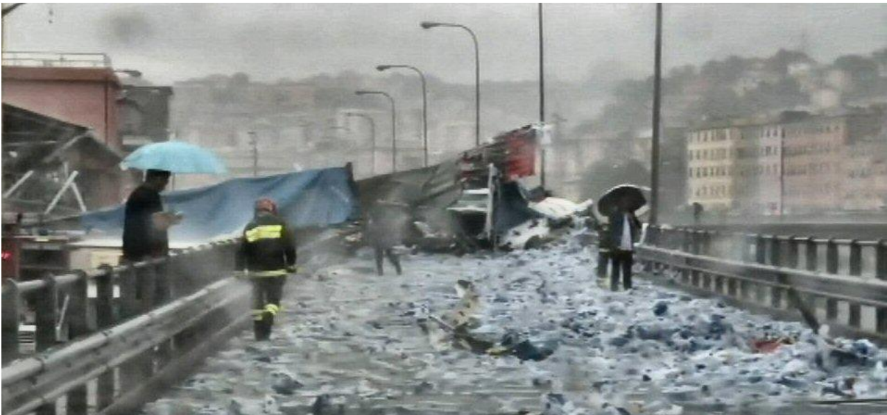
Figure 6 Les pompiers se déplacent sur une surface recouverte de gravier et de petits éboulis de pierres dans toute la zone du viaduc du Polcevera à Cornigliano
