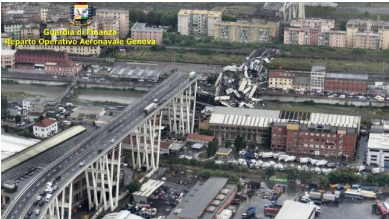
Figure 1 Effondrement du viaduc de Morandi à Gênes sur la photo prise par l'hélicoptère
