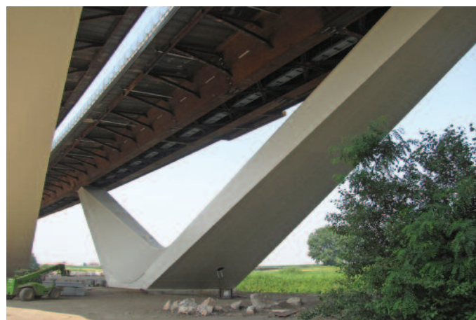
5. Vista del cavalletto metallico del viadotto VI004 P16-P19
