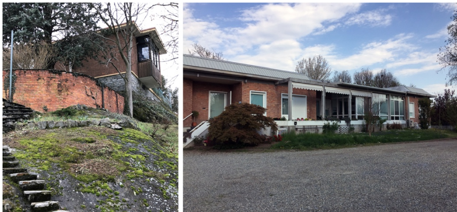
Fig. 6 – Due progetti residenziali: villa Gassino con lo sporto di gronda tinte di giallo paglia; vista su villa Monterevel.
