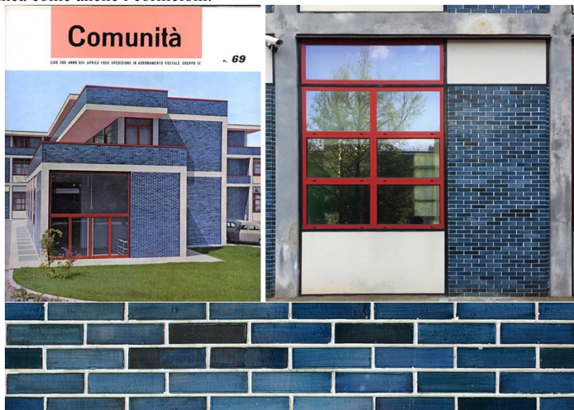
Fig. 8 – Copertina di Comunità del 1959 in cui viene presentata l'opera; scansione modulare della struttura e trattamento cromatico delle superfici; klinker di rivestimento, smaltato e dipinto a mano con tonalità differenti di blu.
