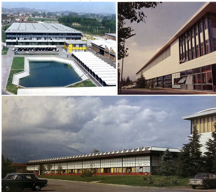
Fig. 9 – Foto storiche del campus Olivetti di San Bernardo, dopo l’abbandono dell’area da parte dell’industria gli edifici sono stati partizionati e pochi mantengono le caratteristiche originali. Una vista d’insieme con l’edificio giallo dell’infermeria e la OMO in primo piano; a destra: il corpo uffici e quello dell’officina della OMO; in basso: l’attrezzaggio.
