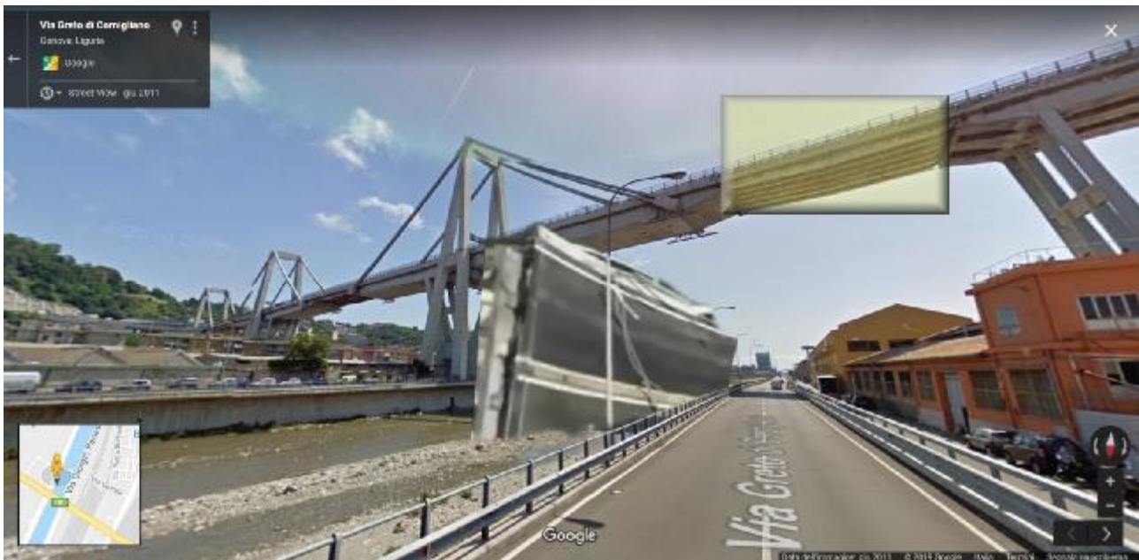
Figura 14 La posición de la cubierta más allá de la "farola" en la carretera del río Cornigliano [Nota 10]
