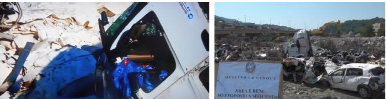
Figura 12. El tractor del tanque entre los escombros del viaducto y ahora en el área de escombros bajo investigación.
