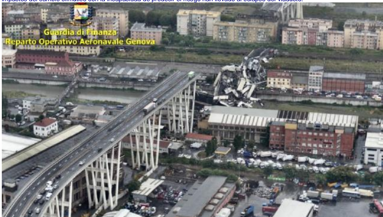
Figura 1 Colapso del viaducto de Morandi en Génova en la fotografía del helicóptero
