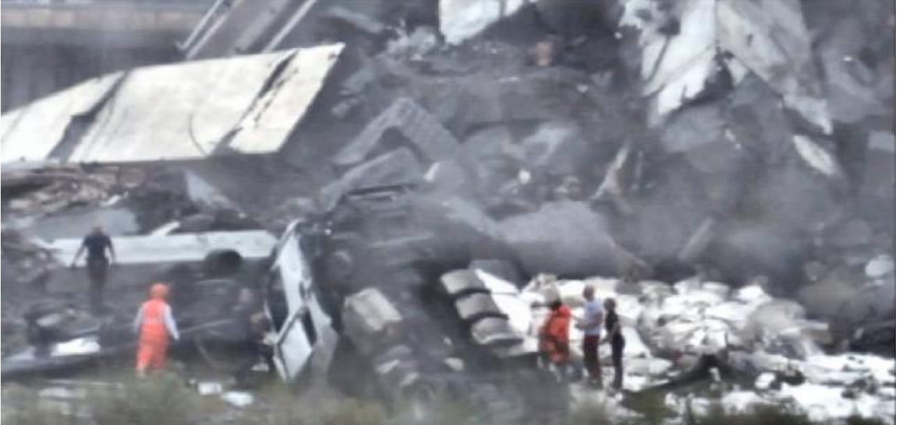
Figura 11. El tractor del tanque entre los escombros del puente..
