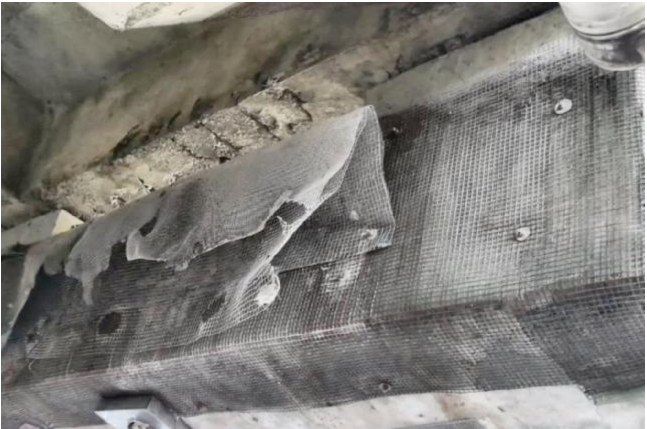
Figura 3 Se colocaron redes para evitar pérdidas
