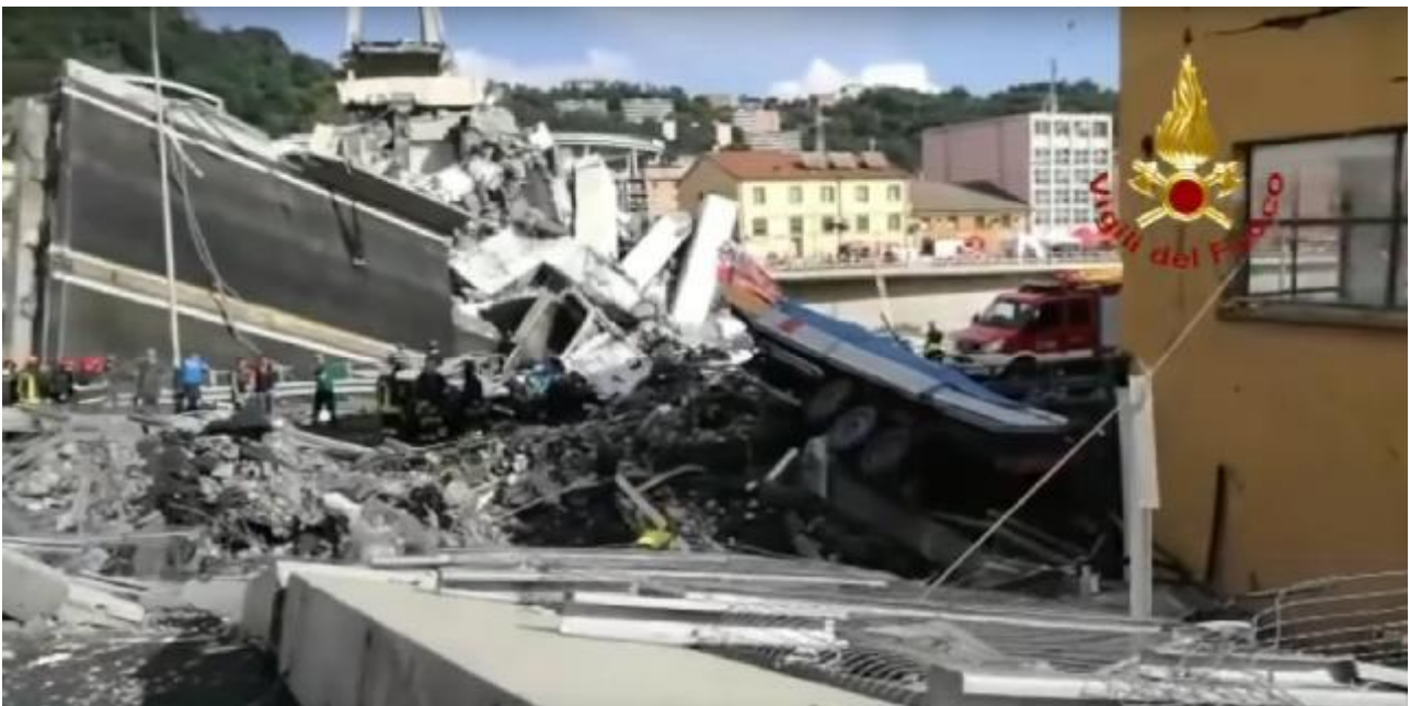
Figura 13 Los techos colapsados de algunos almacenes bajo el viaducto de Morandi
