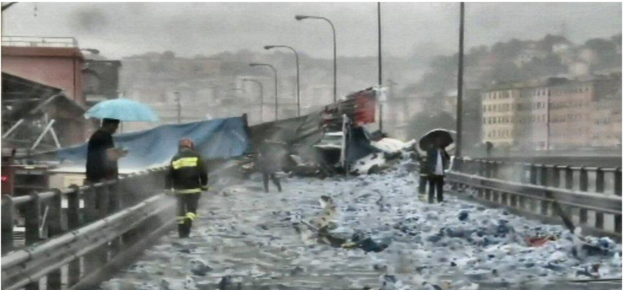
Figura 6 Los bomberos se mueven sobre una superficie de grava y roca pequeña a través del área del viaducto de Polcevera en Cornigliano
