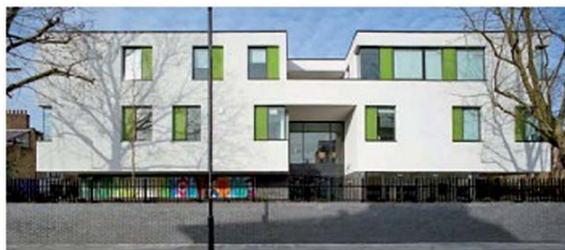
Fronte meridionale dell'edificio - Kentish Town Health Centre (fonte: elaborazione personale)
