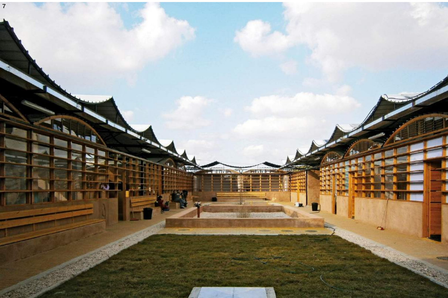
6 -il percorso esterno coperto che definisce la corte -the covered outdoor walkway that forms the courtyard 7 -vista della corte interna con gli spazi per il gioco dei bambini -view of the inner courtyard with play spaces for the children
