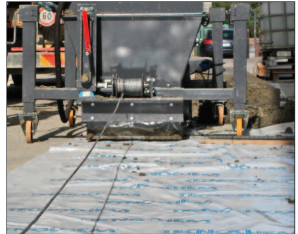
8A, 8B, 8C e 8D. Alcuni particolari della mini slipform
