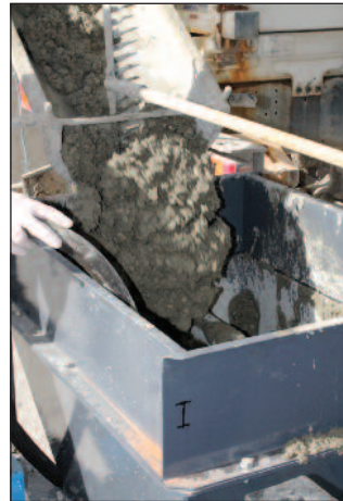
8A, 8B, 8C e 8D. Alcuni particolari della mini slipform
