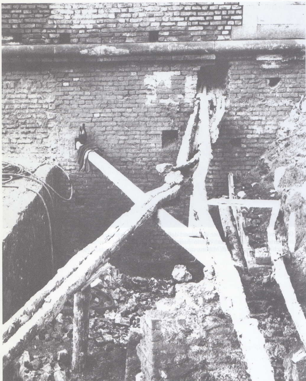
FIG. F - Particolare dei primi assaggi degli scavi per la realizzazione del tunnel della Linea 1 della Metropolitana Milanese: sulla sinistra si riconosce il muro meridionale del rivellino, che sarà smontato nel proseguo dei lavori. Civico Archivio Fotografico di Milano, cart. Scavi della Metropolitana , circa 1959-61.
