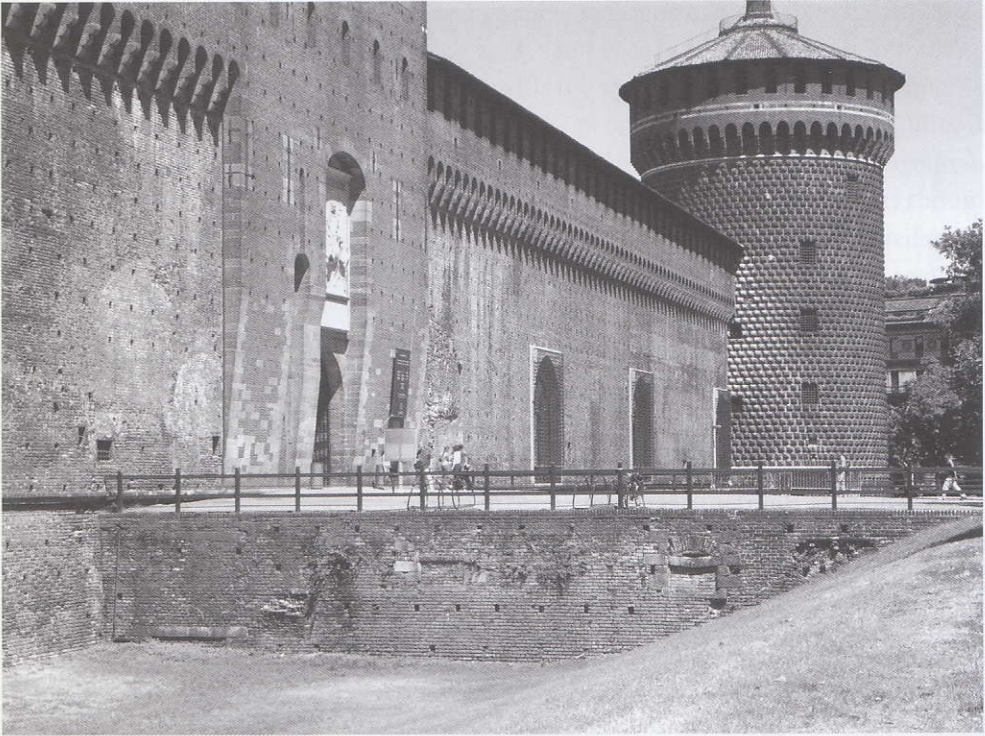
FIG. D - Vista del prospetto meridionale del basamento del rivellino (agosto 2006).
