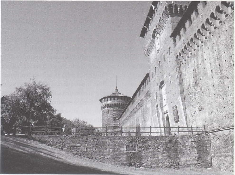
FIG. C - Vista del prospetto settentrionale del basamento del rivellino (agosto 2006).
