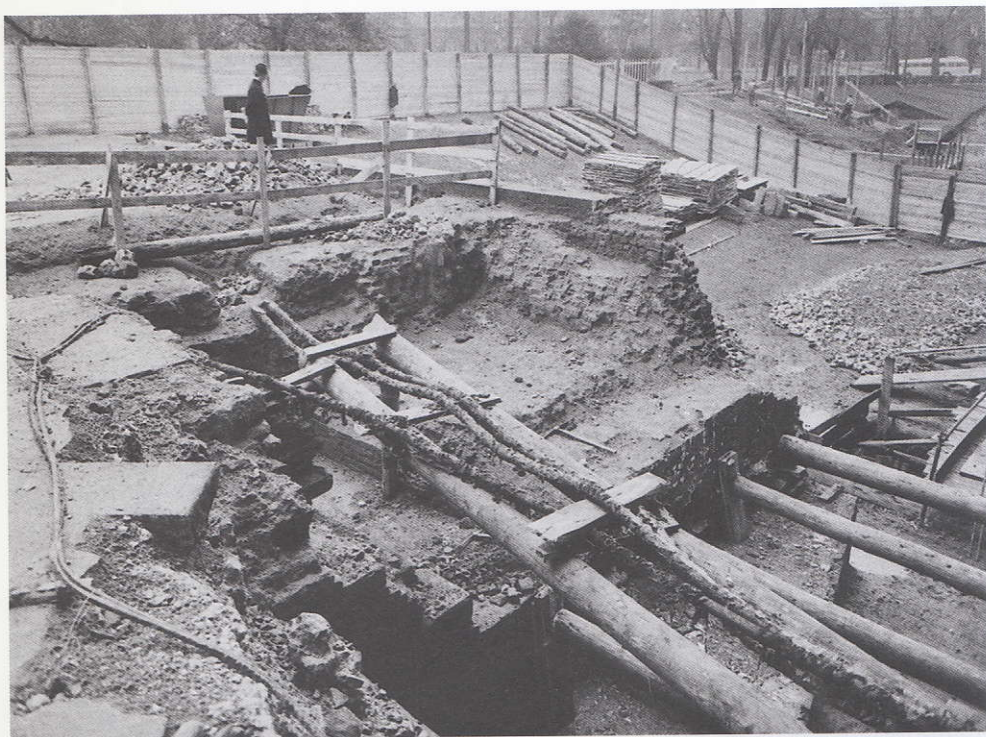
FIG. H - Lo stato del rivellino prima del proseguimento delle demolizioni in direzione di piazza Cairolì durante gli scavi per la realizzazione del tunnel della Linea 1 della Metropolitana Milanese. Civico Archivio Fotografico di Milano, cart. Scavi della Metropolitana , circa 1959-61.
