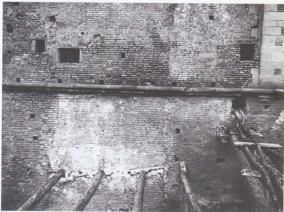
FIG. G - Scavi per la realizzazione del tunnel della Linea 1 della Metropolitana Milanese. Il muro meridionale del rivellino è stato interamente demolito Civico Archivio Fotografico di Milano, cart. Scavi della Metropolitana , circa 1959-61.
