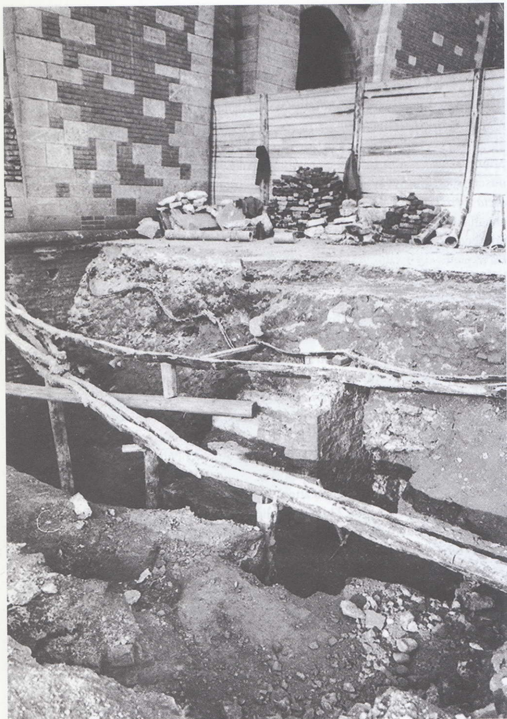
FIG. E - Primi assaggi degli scavi per la realizzazione del tunnel della Linea 1 della Metropolitana Milanese. Civico Archivio Fotografico di Milano, cart. Scavi della Metropolitana , circa 1959-61.
