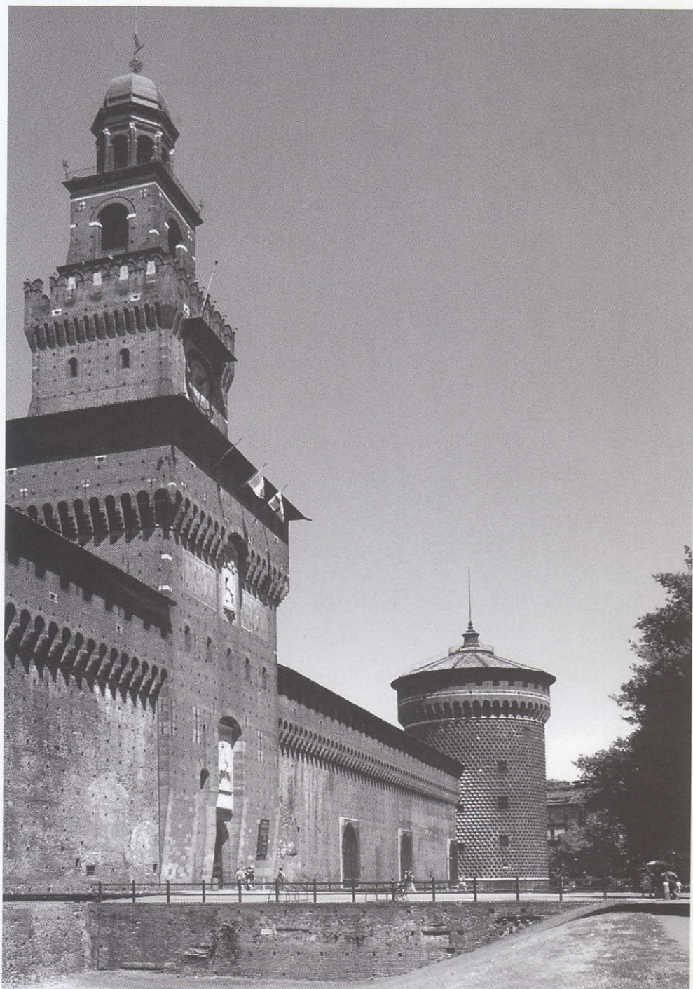
FIG. A - Vista da sud del prospetto principale del Castello, con la base del rivellino verso la città ai piedi della torre Umberto I ricostruita da Luca Beltrami e inaugurata nel 1905 (agosto 2006).
