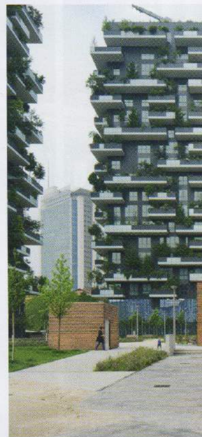
Détail de façade et vue intérieure / Façade detail and interior view, Casa della Memoria, Milan, Italie/Italy.
