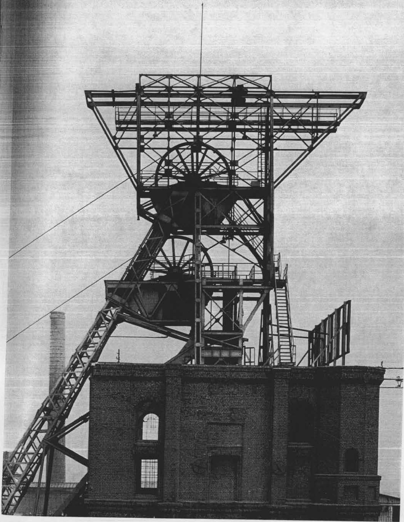
94-95 Förderturm Zeche Helene Schacht Helene Essen-Altenessen Ruhrgebiet Malakowturm erbaut Stahlgerüst 1901 abgebrochen 1968
