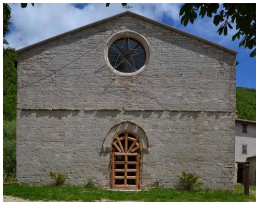
Figura 4 – Facciata con danni limitati
