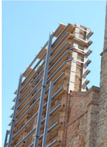
Figura 3 – Messa in sicurezza della facciata danneggiata per rotazione
