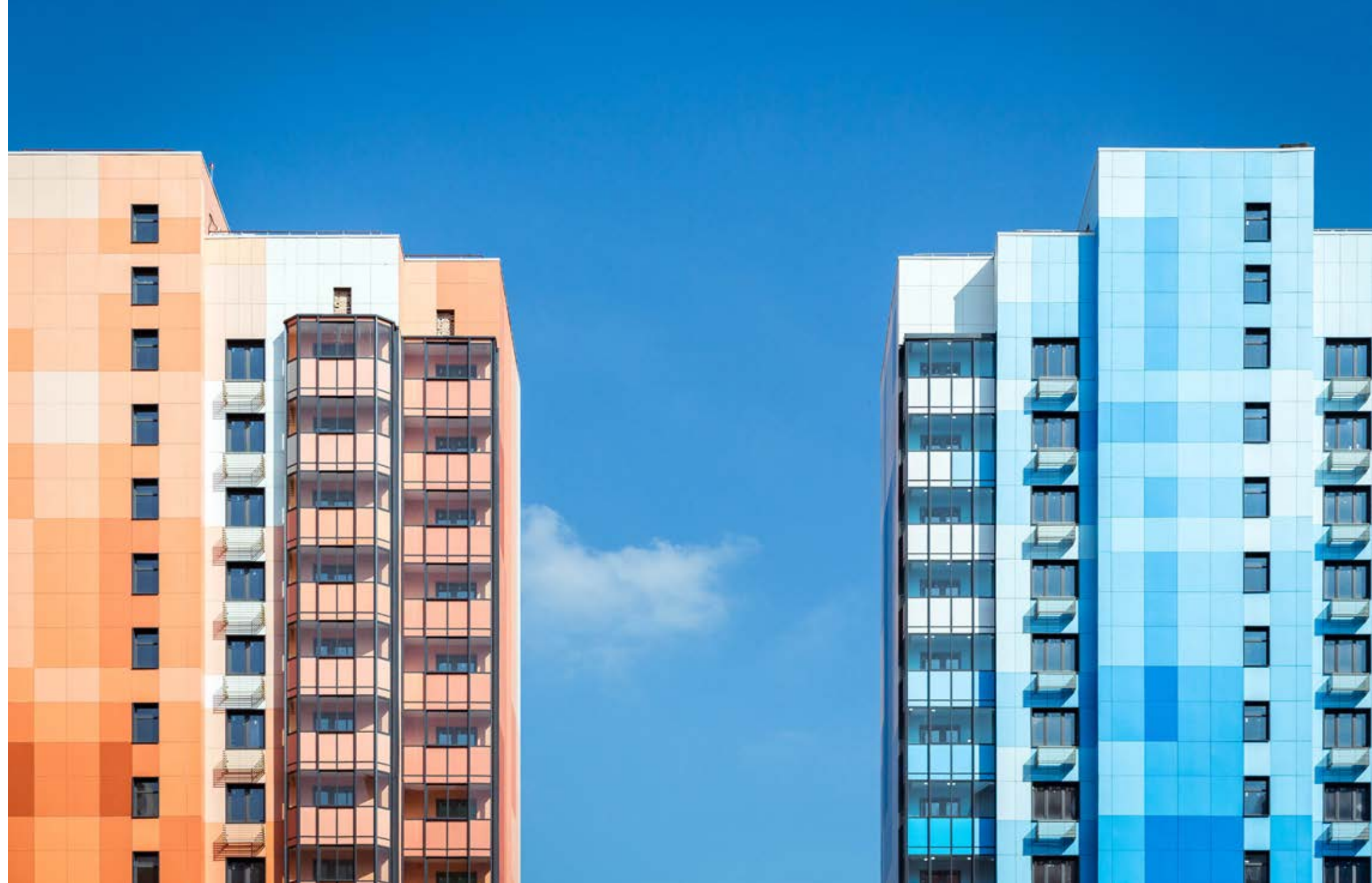
Sopra, i lotti realizzati con i pannelli in fibrocemento, più grandi e più adatti a una composizione articolata in mezzi toni e sfumature. A sinistra, i lotti ricoperti da piastrelle di Kerama , azienda del gruppo Marazzi, che usano fondi omogenei in nero e in bianco con inserti a colori smaglianti. Il progetto si completa con gli edifici di servizio e le attrezzature negli spazi comuni delle corti.
