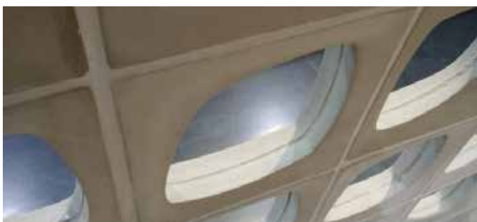
FIGURA 19: Elementos vazados, em concreto pré-moldado, fazendo releitura dos tradicionais cobogós
