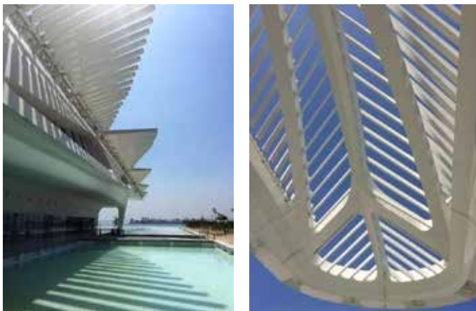
FIGURAS 1 E 2: Museu do Amanhã, Rio de Janeiro. Imagens das estruturas de cobertura e laterais em concreto que definem a plasticidade da obra. Inovação formal, utilizando material tradicional. Arq. Santiago Calatrava.
