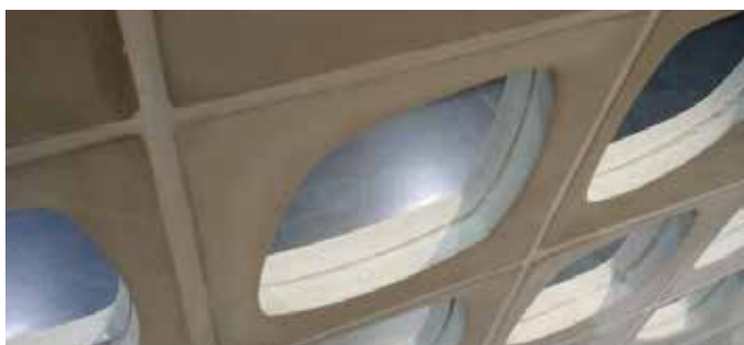
IMM.19: Mattoni forati, in calcestruzzo prefabbricato, con una rilettura dei tradizionali "cobogós" brasiliani
