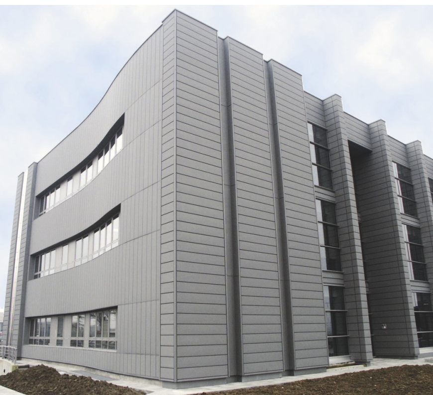
Immagine 10. Prestazioni degli elementi di chiusura in zinco-rame-titanio definite dal trattamento superficiale attraverso il processo di fosfatazione, eseguito per la trasformazione chimica duratura dello strato metallico, e il processo di laccatura, eseguito a livello termico sulle lastre
