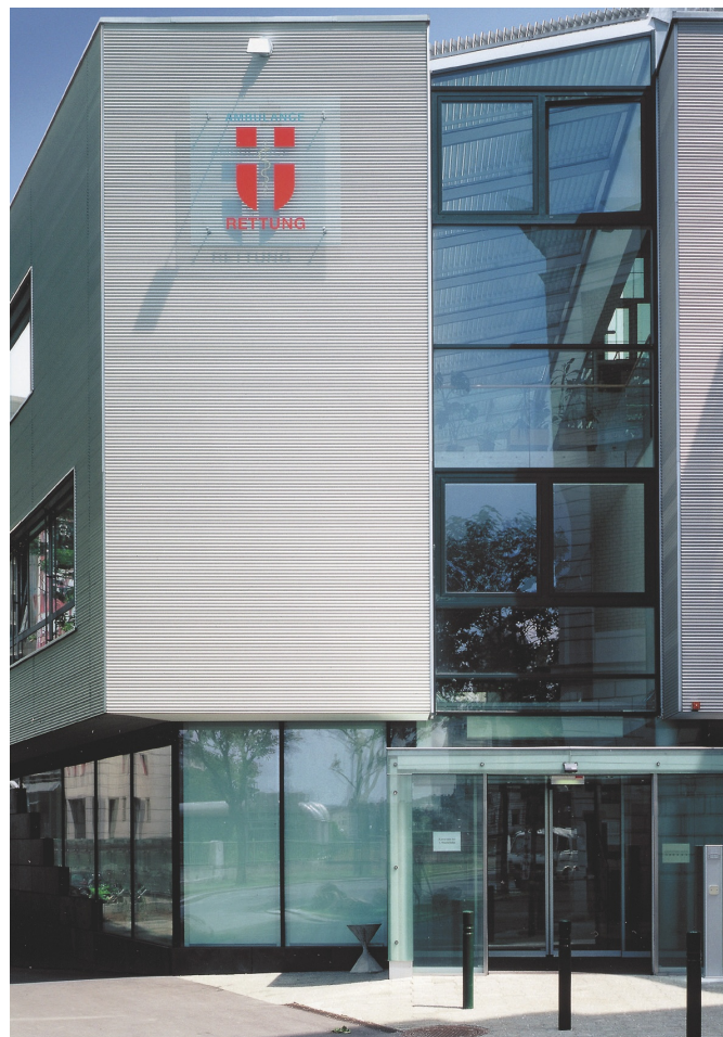
Immagine 5. Integrazione delle chiusure in laminato di alluminio ai sistemi di facciata per mezzo della tipologia con profilo a "Z" (in alluminio anodizzato naturale), della configurazione superficiale a setti angolari regolari e dei giunti longitudinali, con fissaggio scorrevole e nascosto
