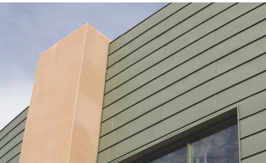
Immagine 9. Condizioni prestazionali ed esecutive delle chiusure in laminato di zinco-rame-titanio in accordo all'incremento della resistenza a tensione, alle deformazioni permanenti e all'assemblaggio mediante i giunti a incastro con fissaggio a scomparsa
