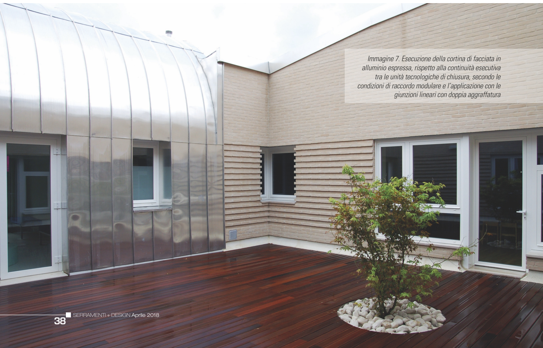
Immagine 6. Applicazione dell'involucro in alluminio secondo la combinazione eseguita dalla tipologia a "cassetta", per la realizzazione di facciate retroventilate, dalla tipologia a elementi planari, gofrati o lisci, e dalla tipologia in nastro preverniciato
