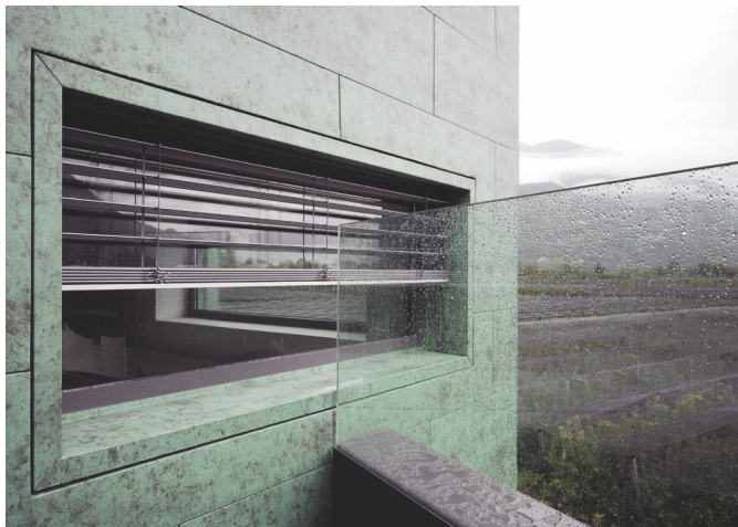
Immagine 6. Applicazione dell'involucro in alluminio secondo la combinazione eseguita dalla tipologia a "cassetta", per la realizzazione di facciate retroventilate, dalla tipologia a elementi planari, gofrati o lisci, e dalla tipologia in nastro preverniciato
