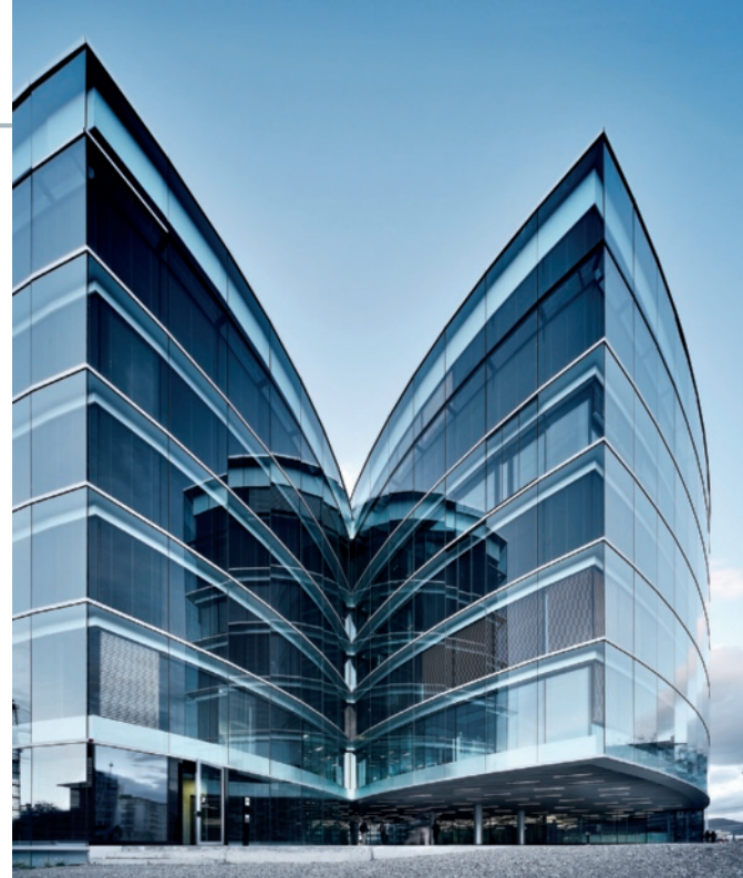
Immagine 7. Applicazione e funzionamento del sistema di facciata a doppia parete, secondo la combinazione tra il tamponamento interno in vetro triplo, la schermatura esterna in vetrocamera e l'intercapedine diretta alla calibrazione delle condizioni termo-igrometriche
