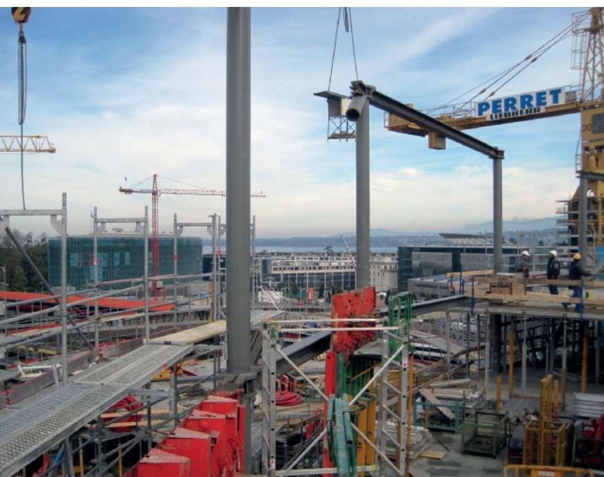
Immagine 2 (sotto). Costruzione dell'apparato strutturale diretto alle interfacce e agli allineamenti planari dei componenti di facciata
