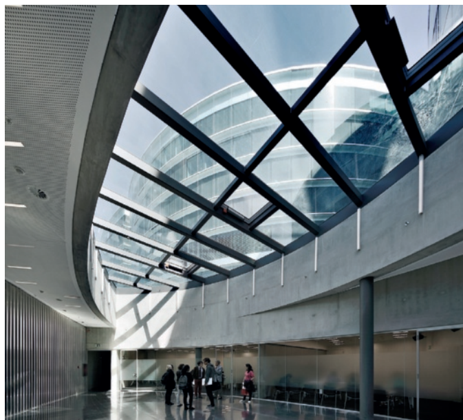
Immagine 6. Esecuzione dell'involucro superiore di conformazione lenticolare, sostenuto dal reticolo strutturale orizzontale
