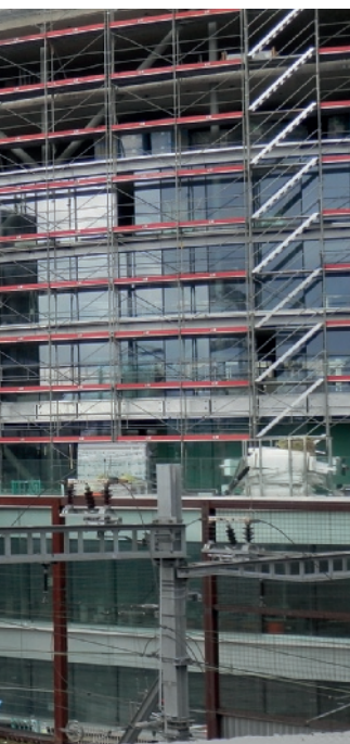
Immagine 4. Costruzione del sistema di facciata secondo le modalità connettive nei confronti delle interfacce strutturali in c. a. e in acciaio
