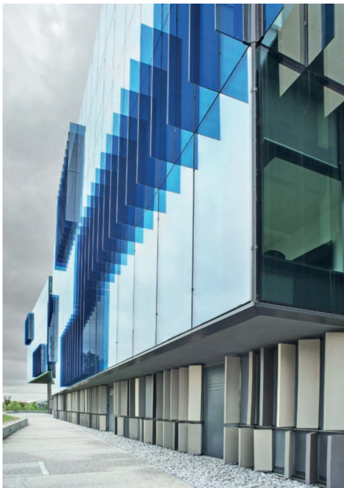
Immagine 9. Esposizione della continuità dell'involucro: interfaccie di giunzione tra i traversi di telaio (per la proiezione all'intradosso strutturale di solaio) e applicazione dei traversi intermedi
