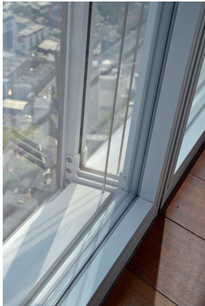
Funzionamento del sistema a doppio involucro: riduzione del passaggio radiante e ventilazione naturale dell'intercapedine (secondo l'apertura orizzontale tra le sezioni consecutive verticali delle schermature esterne)
