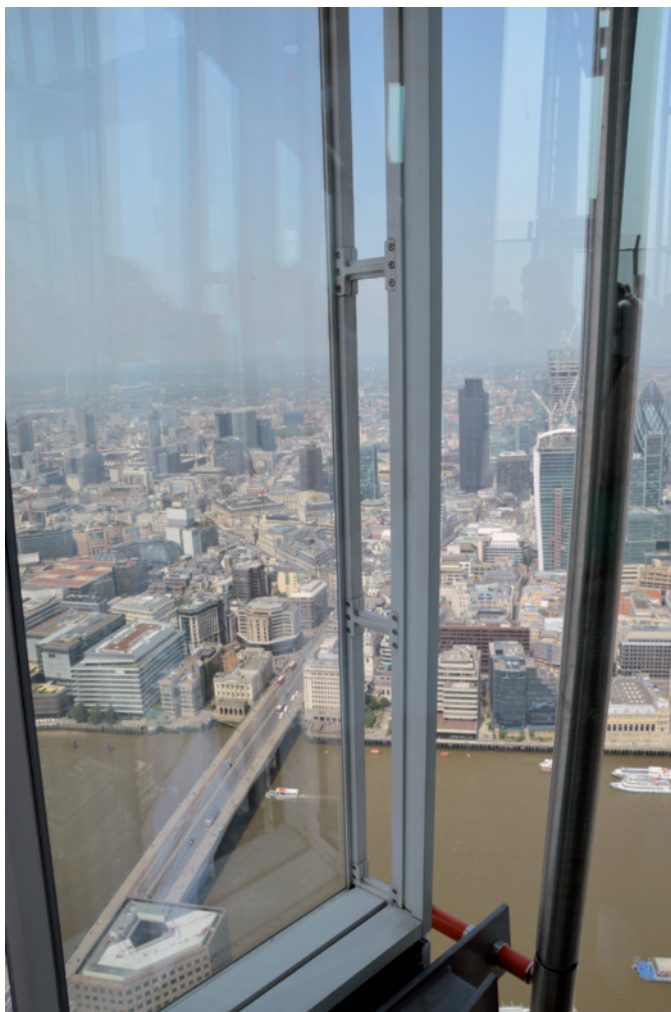
Componenti modulari a cellula: interposizione dei traversi a supporto dei setti scatolari protesi verso la cornice esterna in alluminio, per il sostegno della schermatura in vetro
