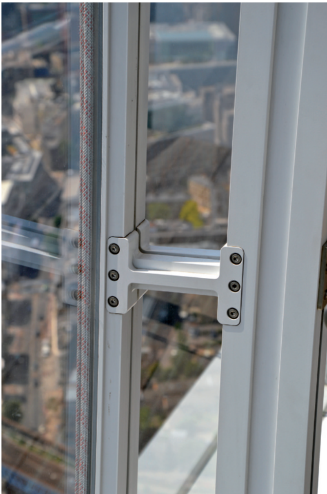
Estensione delle cornici a supporto delle schermature esterne e proiezione laterale degli elementi alari a contenimento perimetrale delle lastre in vetro stratificato
