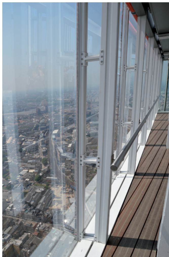
Componenti modulari a cellula: intelaiatura in alluminio a taglio termico realizzata dalle sezioni a doppio profilo scatolare a sostegno del tamponamento in vetrocamera (con apribile a battente)
