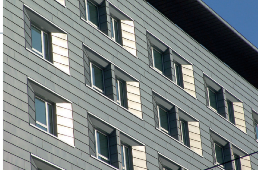
Esecuzione dell'involucro in zinco-titanio, con orditura delle connessioni per doppia aggraffatura
