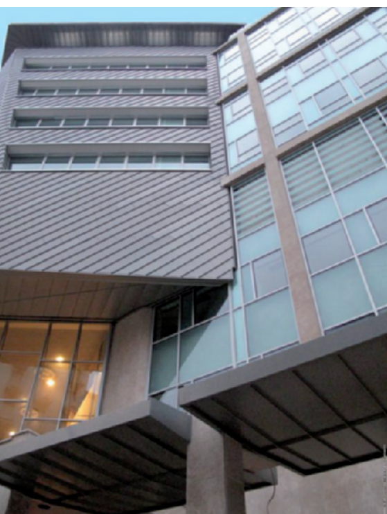
(a sinistra) Realizzazione dell'involucro lapideo: interfaccia tra i sistemi di involucro e sviluppo della modulazione di facciata. (sopra) Tessitura del sistema di facciata a montanti e traversi e modulazione speculare delle specchiature
