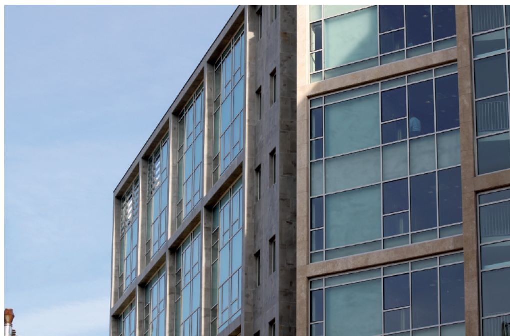
(a sinistra) Realizzazione dell'involucro lapideo: interfaccia tra i sistemi di involucro e sviluppo della modulazione di facciata. (sopra) Tessitura del sistema di facciata a montanti e traversi e modulazione speculare delle specchiature
