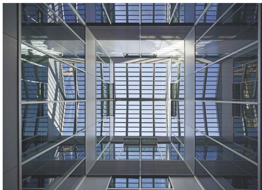
Immagine 5. Realizzazione dei pozzi luce interni all'ala Nord, composti dal sistema di facciata vetrata su quattro lati e coperti dal tetto con chiusure in vetro, dotato del sistema di finestre a lamelle apribili (foto OskarDaRiz)
