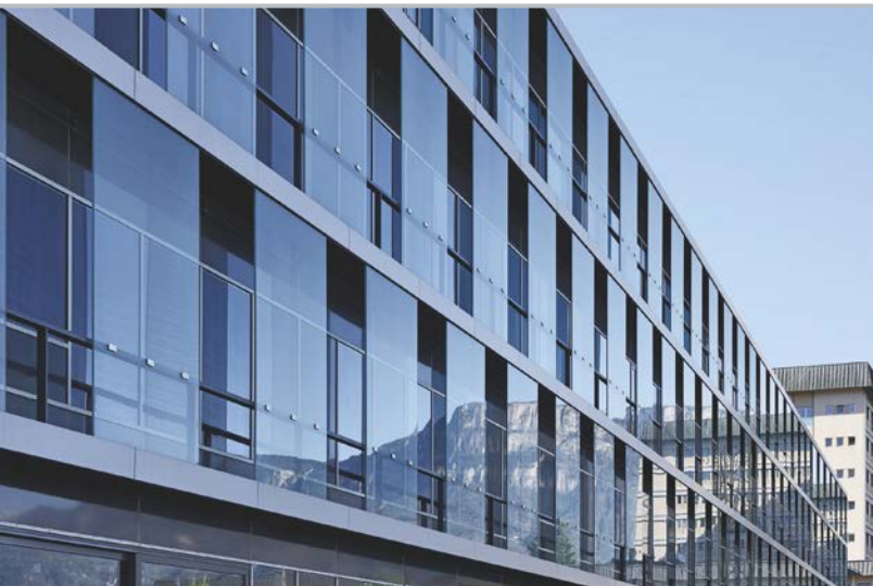
Immagine 3. Realizzazione del sistema di involucro inerente alla facciata principale (ala nord) secondo la tipologia a "doppia parete", con tamponamento di tipologia a telai e chiusure in vetrocamera e con struttura esterna in acciaio e chiusure in vetro serigrafato (foto OskarDaRiz)
