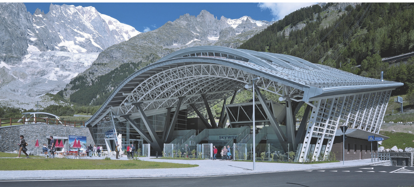
Immagine 3. Apparato strutturale reticolare in acciaio e chiusure di involucro nella tipologia a montanti e traversi, provvista di infissi a elevate prestazioni termiche
