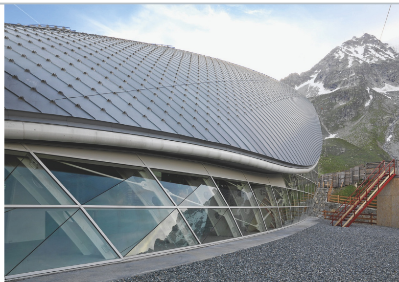
Immagine 5. Esecuzione delle cortine di facciata nella tipologia a montanti e traversi e integrazione degli infissi a elevate prestazioni energetiche
