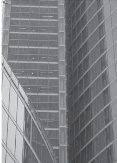
Pei Cobb Freed & Partners, Caputo Partnership e Sistema Duemila, Palazzo Lombardia, costituzione funzionale delle sezioni di facciata
