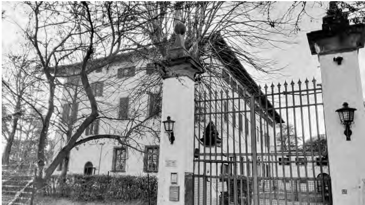
Il complesso di villa Il Palagio
