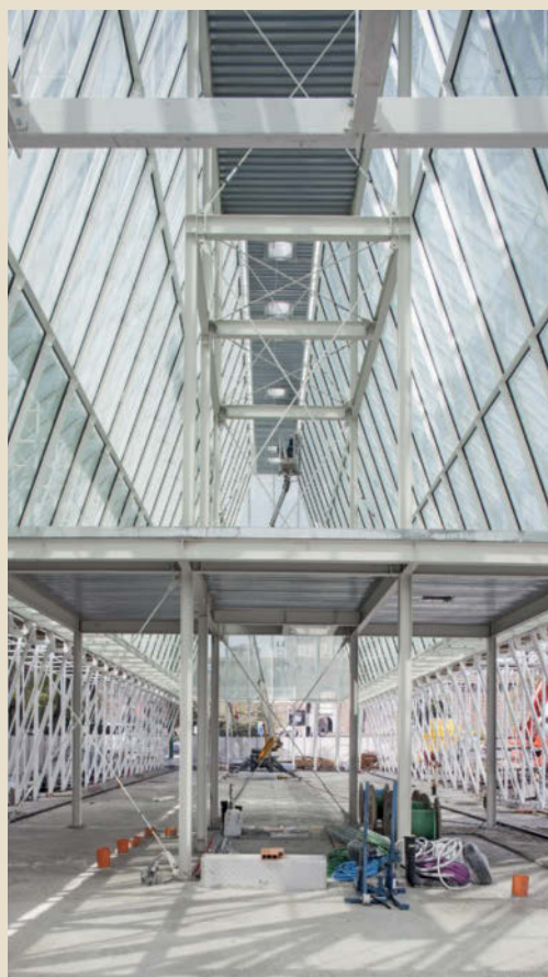
Studio Scandurra, Expogate, Milano: montaggio delle pannellature vetrate agli elementi reticolari bidimensionali e tridimensionali in profili tubolari di acciaio (produzione Stahlbau Pichler). (immagine di Filippo Romano)
