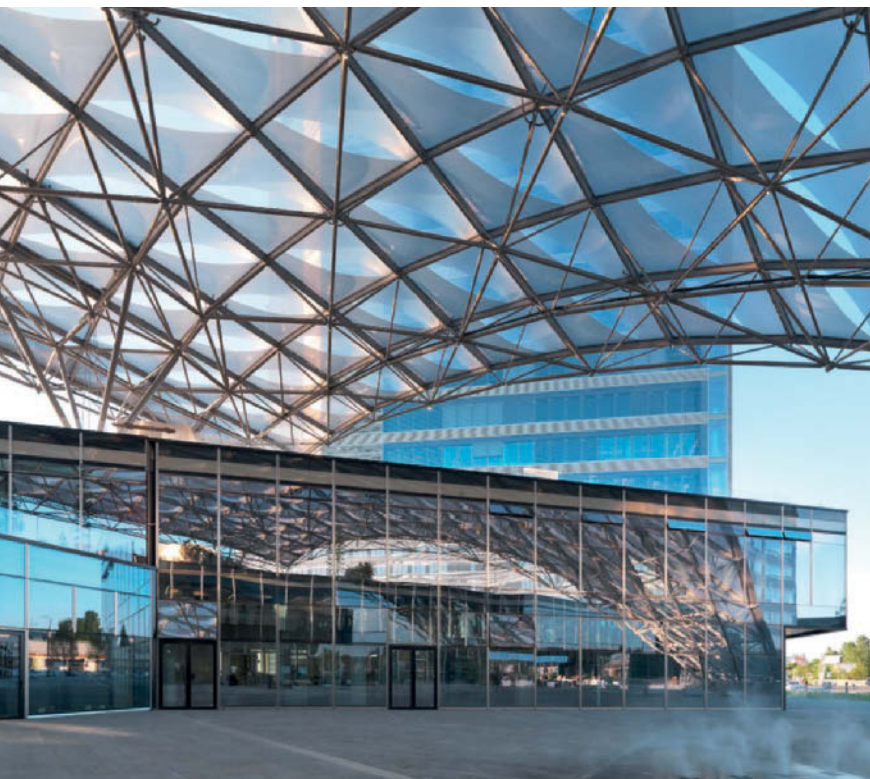
Composizione urbana e articolazione prospettica: interfacce percettive e funzionali tra le chiusure della piastra connettiva multifunzionale e della "vela" con elementi di involucro in EFTE sull'orditura metallica reticolare
