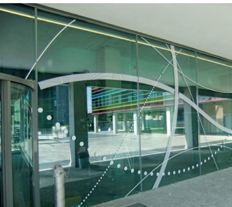
Immagine 4. Costituzione del sistema di facciata e delle chiusure in vetrocamera al piano terra, definite dall'applicazione dei motivi decorativi serigrafati
