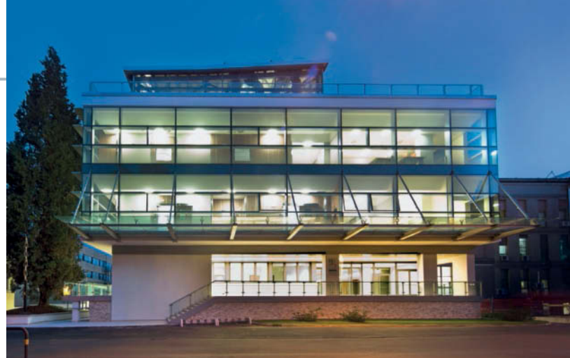
Immagine 1. Applicazione dei sistemi di facciata e integrazione alle morfo-tipologie a destinazione sanitaria: utilizzo delle cortine di involucro e di rivestimento per la nuova edificazione e per l'interazione espressiva con il costruito esistente
