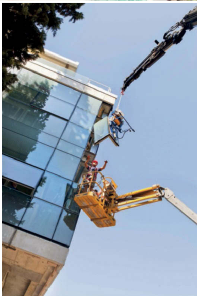
Immagine 6a (sopra) e 6b. Realizzazione del sistema di involucro secondo la posa strutturale verso i profili di telaio, collegati ai setti del perno centrale lineare ed estesi verso il raccordo planare alla facciata
