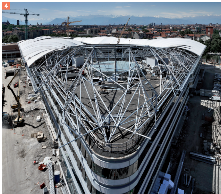
4 Elaborazione del sistema di facciata relativo al "tamburo" e applicazione della trama metallica per il sostegno della copertura a "vela"
