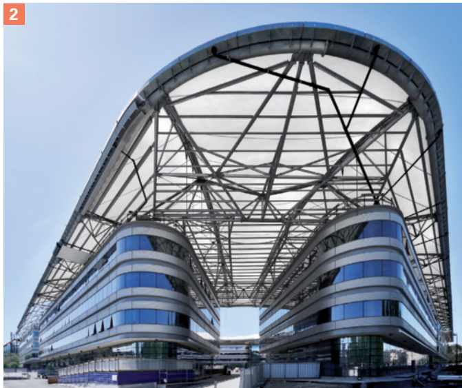
Definizione sinuosa delle proiezioni prospettiche e del sistema di copertura: interfaccia tra la cortina a "nastro" in cellule orizzontali (con vetrazione strutturale) e i componenti spandrel marcapiano (in lamiera ondulata)
