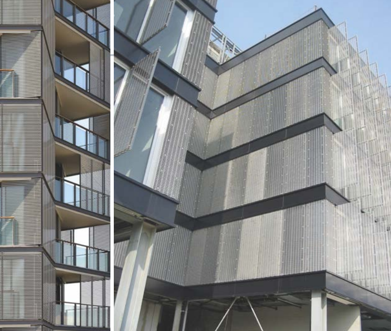
A sinistra. Installazione esterna mobile di persiane scorrevoli, secondo l'applicazione su guide orizzontali e parallele al piano di facciata, con l'ausilio di elementi lamellari piani o inclinati, eseguite rispetto alla Torre Aquileia a Jesolo, progettata da Carlos Ferrater
