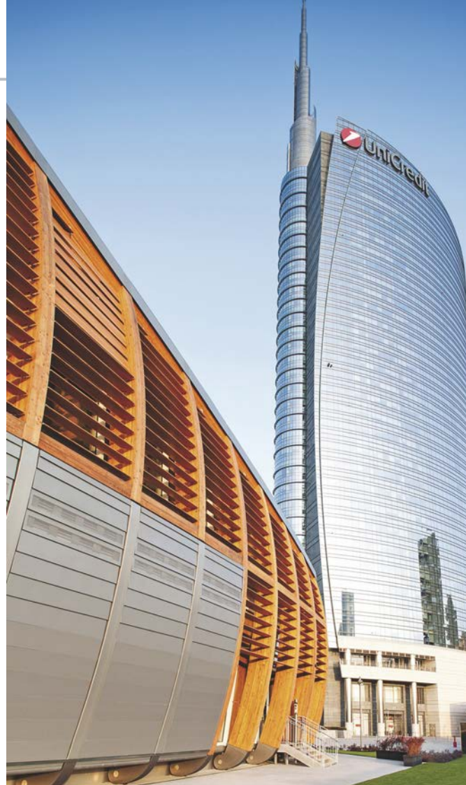
Applicazione delle schermature attraverso la trama avvolgente esterna assemblata alle centine in legno lamellare
