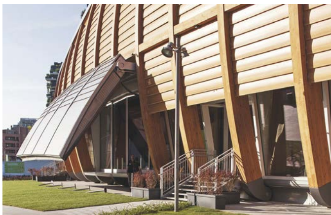
Trama portante in legno lamellare, studiata secondo apparati lineari di tipo beam e la discretizzazione delle centine
