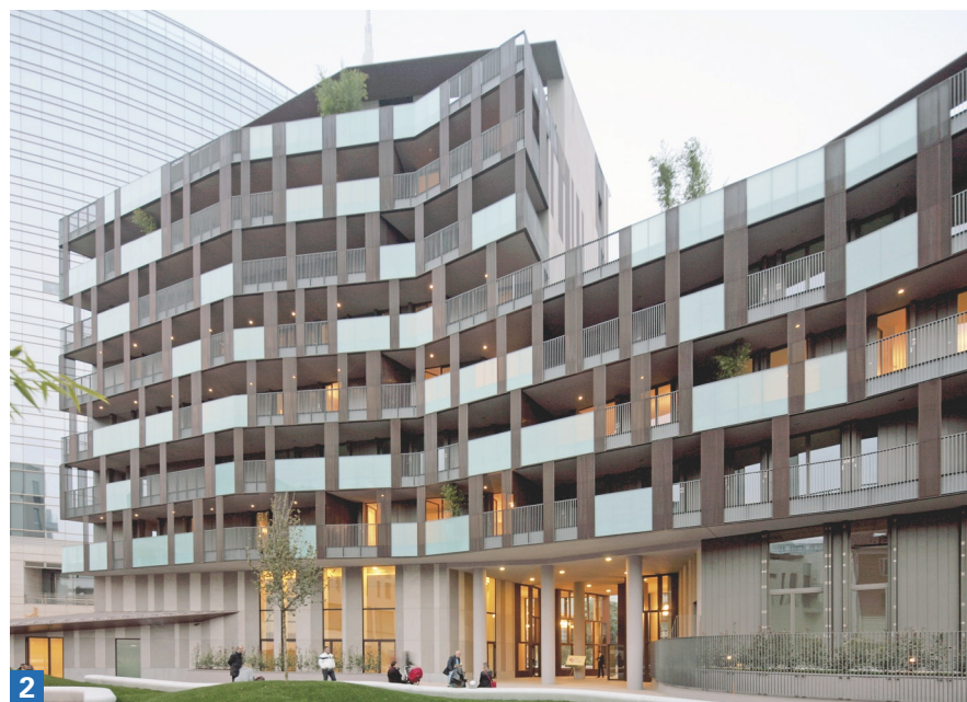
Immagine 1. Composizione del sistema di facciata (prospetto Est): transizione verso l'assetto urbano, dimensione trasversale e conformazione "trapezia"
