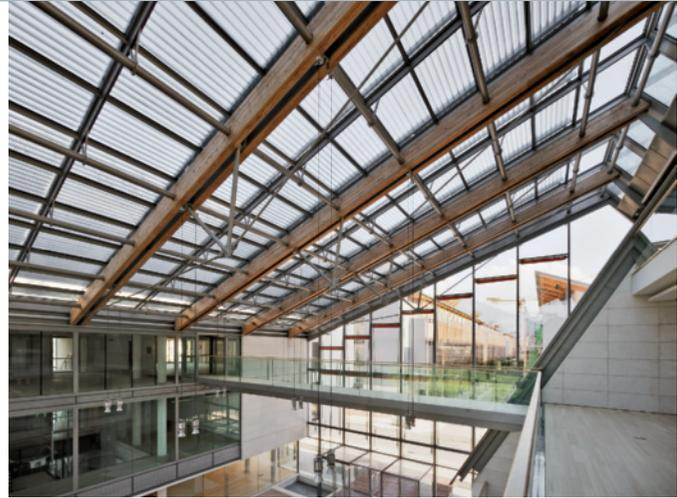
*Realizzazione della lobby: sistema di "facciata-copertura" eseguito tramite l'intelaiatura in profili di alluminio "customizzati" basati sulla tipologia Poliedra 50 CV (produzione Metra)*
