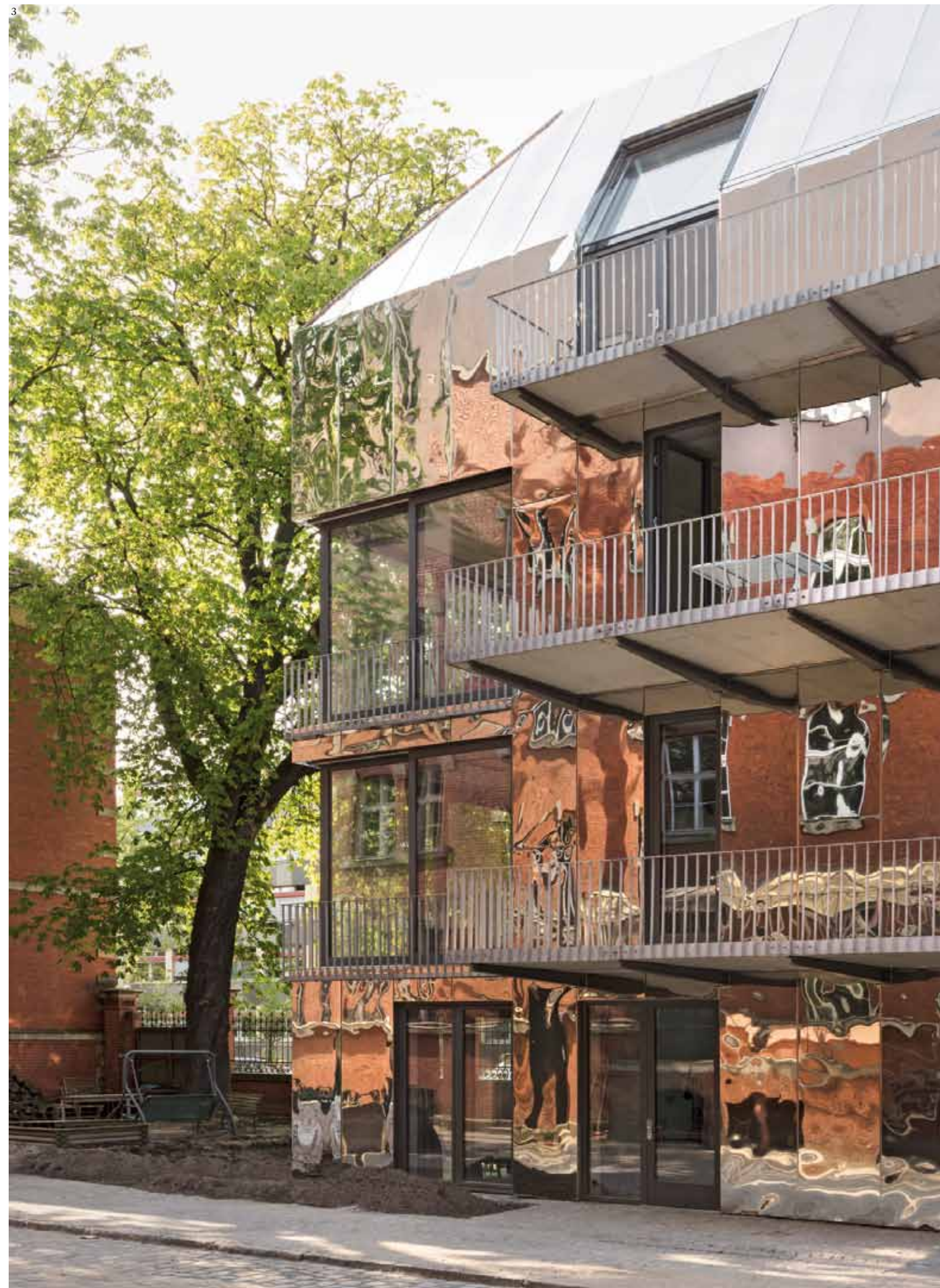
3 dettaglio della facciata sud detail of the southern facade
