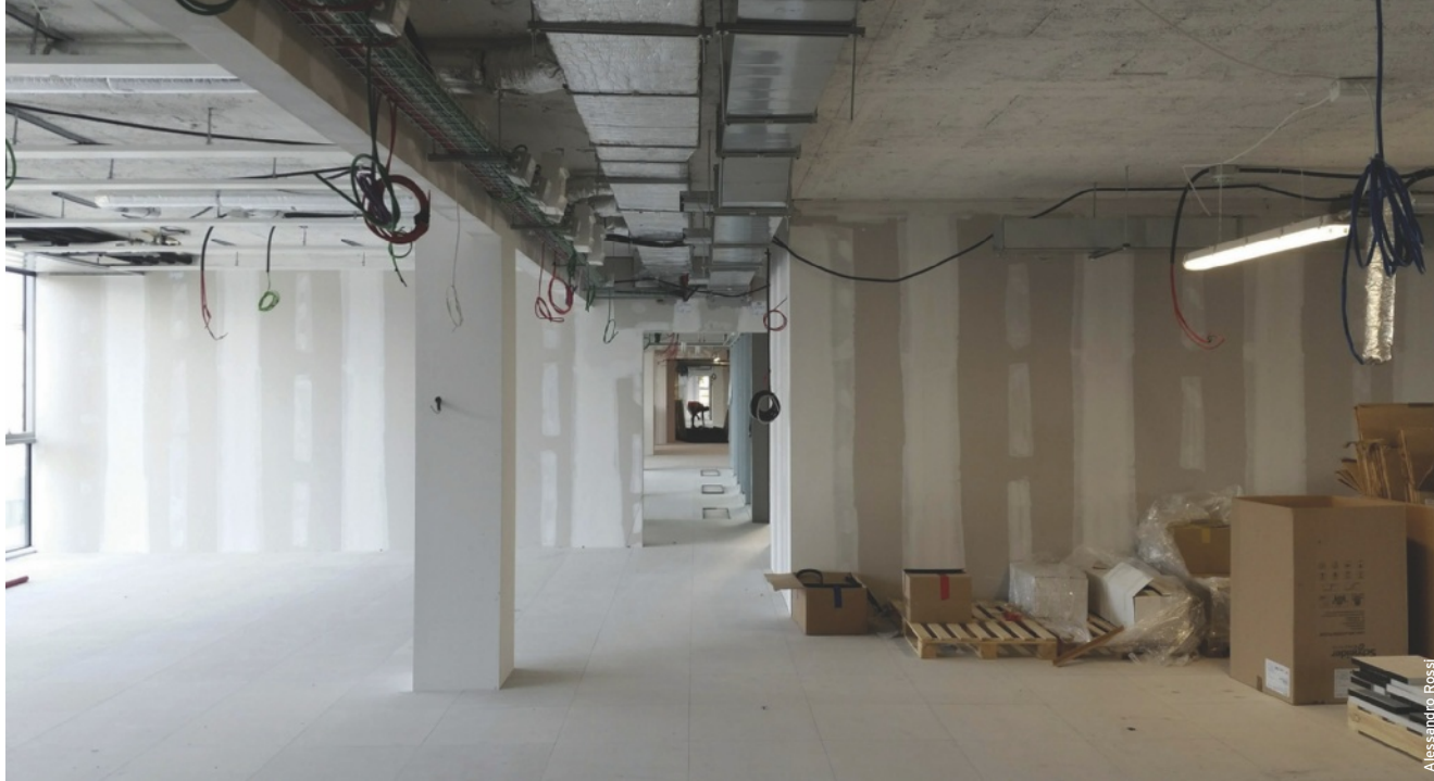
Vista dell'interno con allestimento in struttura leggera Internal view with installation of the light-weight structure
