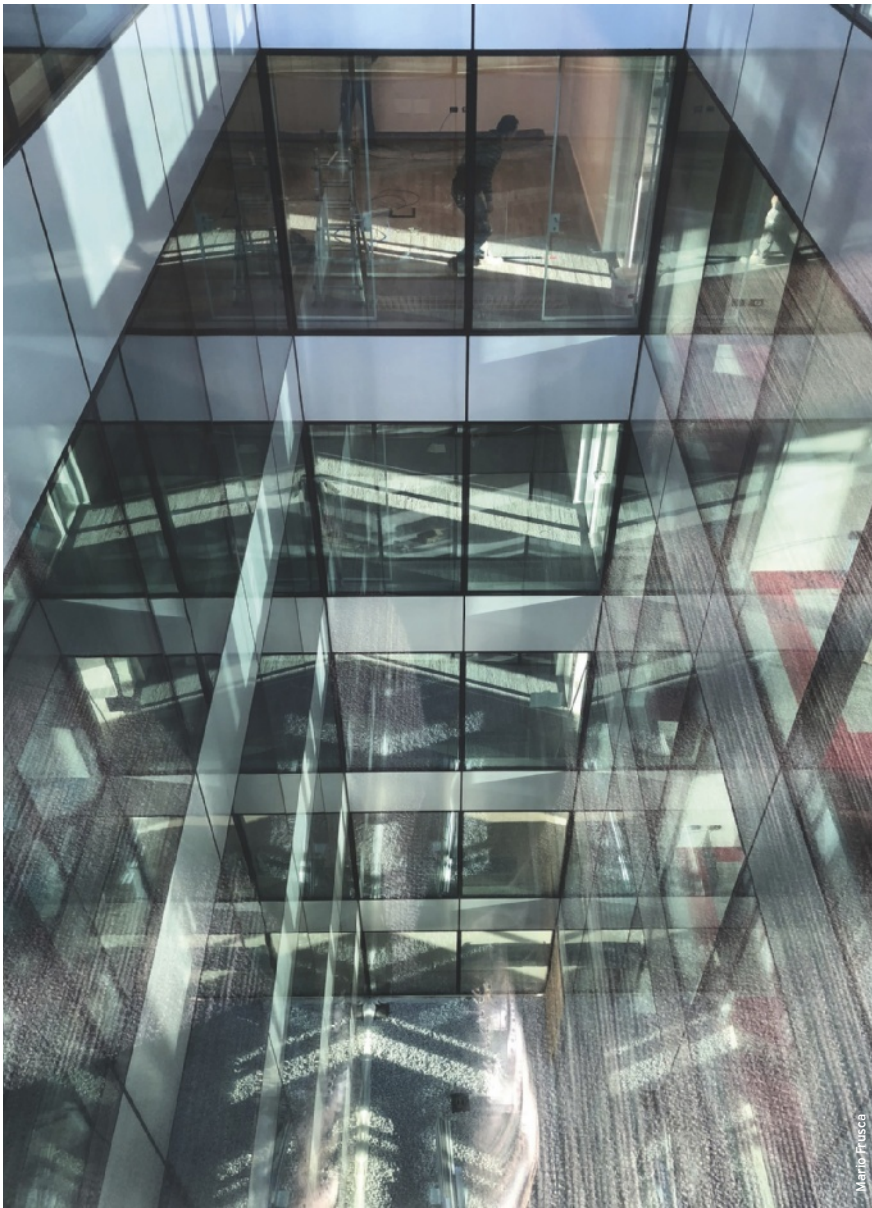
Vista dei patii interni con alternanza di vetro e rivestimenti opachi in alluminio View of the internal atria with alternation of glass and aluminium opaque cladding
