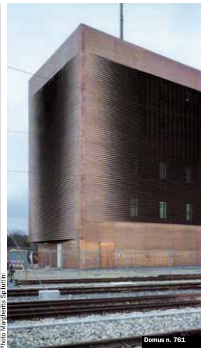
1994 Rivestimento in rame per la cabina di controllo Auf dem Wolf di Herzog & de Meuron, a Basilea/Central signal tower Auf dem Wolf wrapped with copper by Herzog & de Meuron, in Basel
