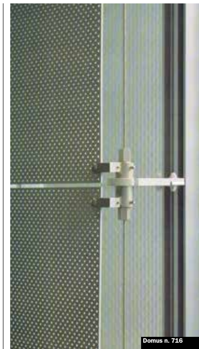
1990 Schermo traforato e tiranti nel Tepia Pavilion di Fumihiko Maki a Tokyo/ Perforated screen and tie rod on the Tepia pavilion by Fumihiko Maki in Tokyo
