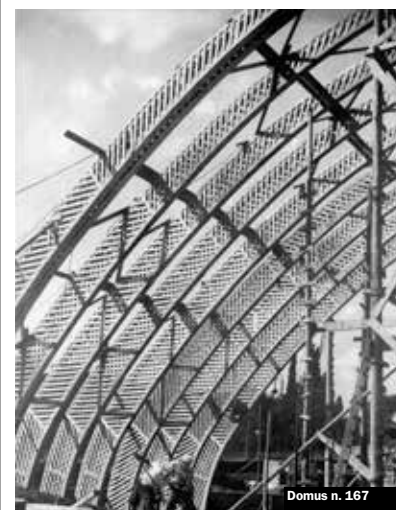
1941 Gli archi in legno di 38 metri di luce del Padiglione delle Armi a Roma/Wood arches with a 38-metre span for the weapons pavilion of a mineral-resources expo in Rome
