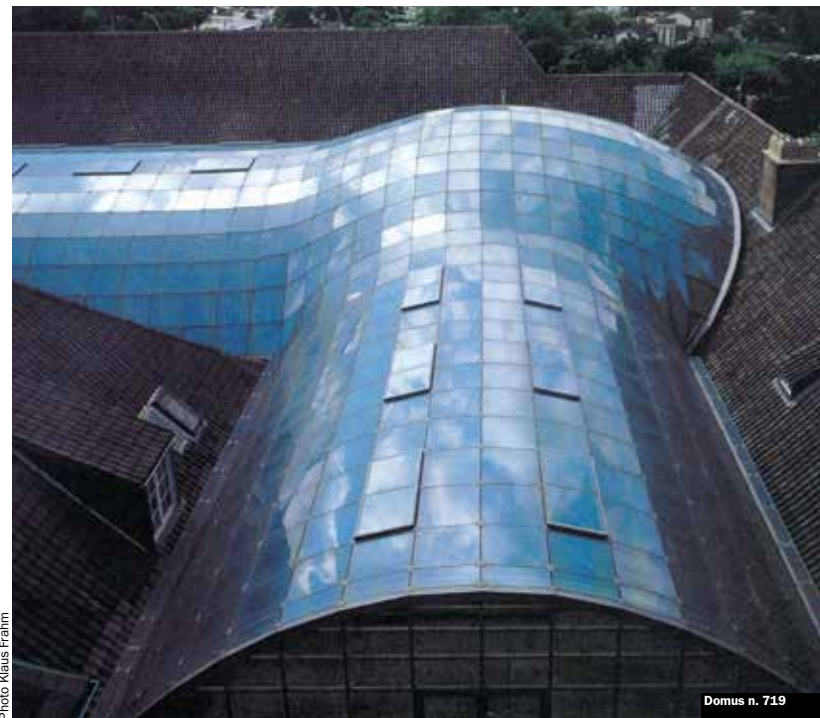
1990 La copertura in vetro e acciaio sul cortile del Museo di Amburgo/ The indoor court of the Hamburg Museum covered with a glass and steel roof
