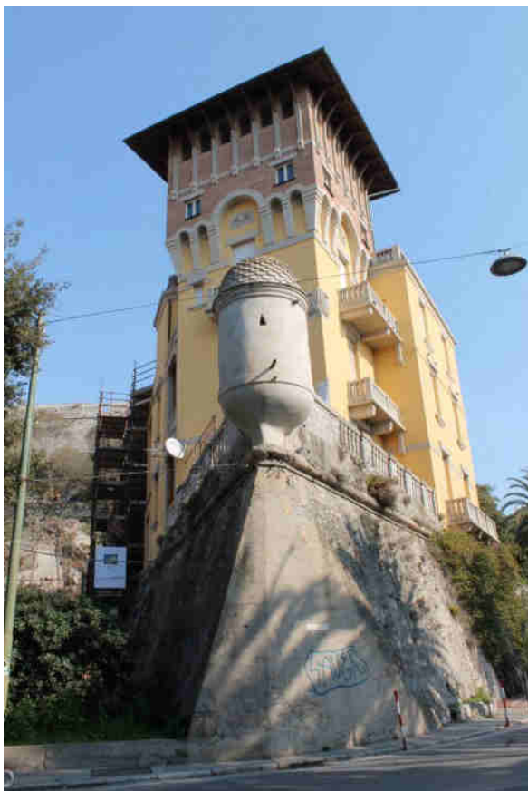
Fig. 5- Castelfranco: vista del baluardo San Pietro, lungo la SS 1 "Aurelia". A sinistra, sullo sfondo, si intravede la fortezza
