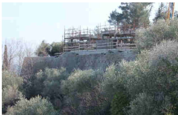
Fig. 13- Vista del fianco del mezzo baluardo San Jago e del cantiere per la costruzione di nuovi corpi di fabbrica
