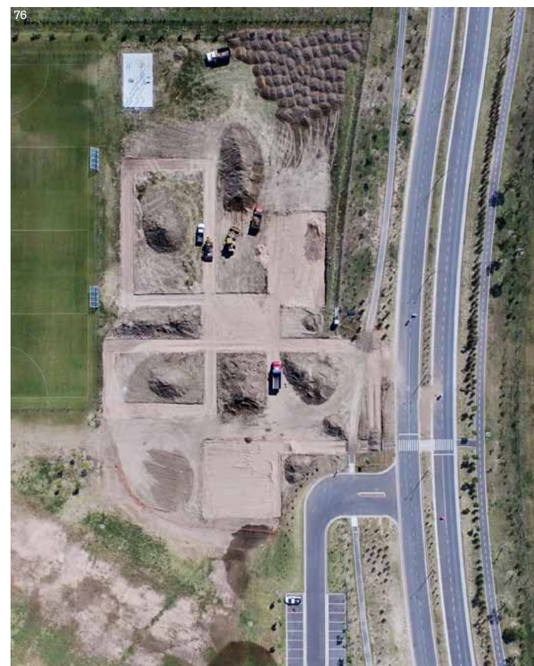
76 —vista zenitale del cantiere ove è riconoscibile l'impronta degli edifici in via di realizzazione —zenithal view of the worksite showing the footprint of the future buildings
