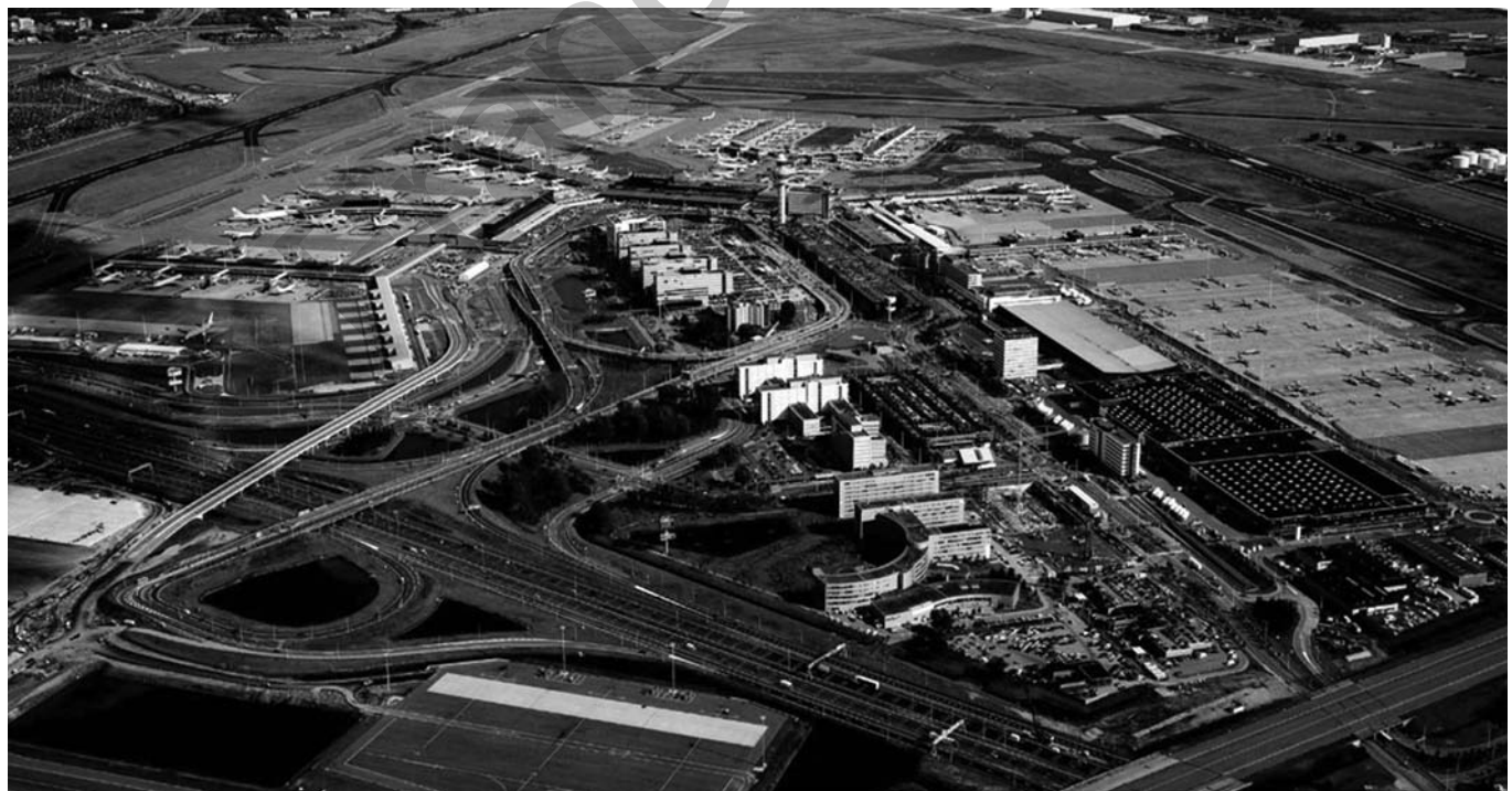
L'aeroporto di Schiphol: il terminal, alcune attività della airport area, parte dell'edificato urbano di Amsterdam sullo sfondo
