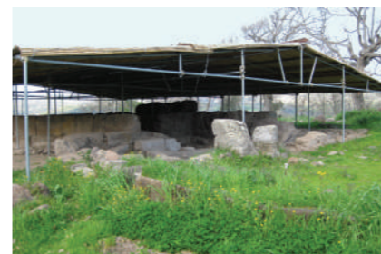
FIGURA 17 MONTE (OR): IL TEMPIO NURAGICO, COPERTURA IN CANNE DI LAGO E STRUTTURA IN ACCIAIO (FOTO DELL'ING. EVA PATHE, MARZO 2009)
