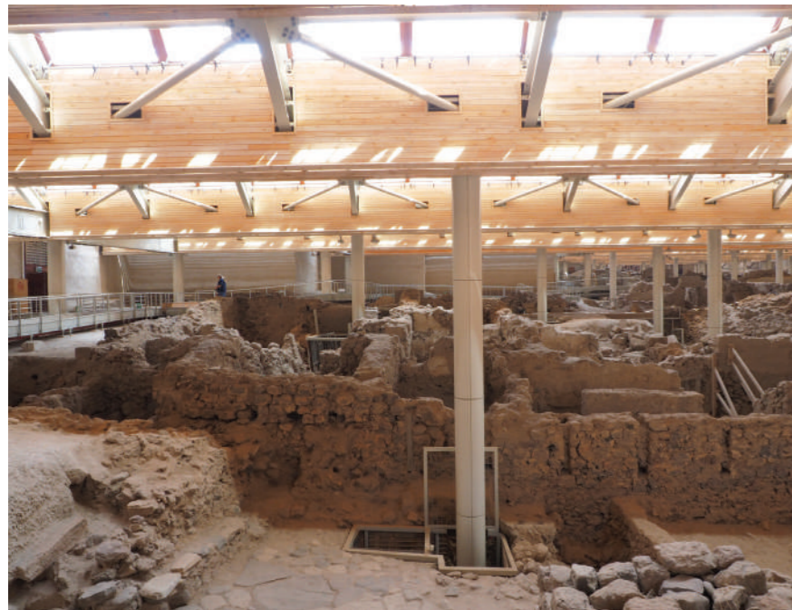
FIGURA 12 SANTORINI (GRECIA): AREA ARCHEOLOGICA DI AKROTIRI. LA COPERTURA DELL'AREA DI THERA COPRE PIÙ DI 11000 MQ, IN ZONA AD ELEVATO RISCHIO SISMICO ED IN UN CONTESTO AMBIENTALE SFIDANTE PER LA PRESENZA DEL MARE. RAPPRESENTA IN MODO ESEMPLARE LA TENDENZA ATTUALE DI PRESERVARE INTERE AREE, PIUTTOSTO CHE OGGETTI SINGOLI O ESEMPLI. NONOSTANTE L'UTILIZZO DI AGGIORNATE TECNICHE COSTRUTTIVE SOSTENIBILI [18] PER SFRUTTARE AL MEGLIO LE CONDIZIONI CLIMATICHE ESISTENTI AL FINE DI GARANTIRE L'OTTIMALE CONSERVAZIONE E FRUIBILITÀ DELLA CITTÀ DI THERA, LE DIMENSIONI, PROFONDITÀ DEL PIANO DI APPOGGIO E ANCORAGGI DELLA STRUTTURA PORTANTE APRONO INTERROGATIVI SULLA OPPORTUNITÀ DI COMPIERE LE NECESSARIE OPERAZIONI DI SCAVO E DI TRASPORTO/ASSEMBLAGGIO DI MATERIALI INGOMBRANTI E PESANTI SU DI UN'AREA ARCHEOLOGICA COSÌ VASTA, ANCORA OGGETTO DI STUDIO
