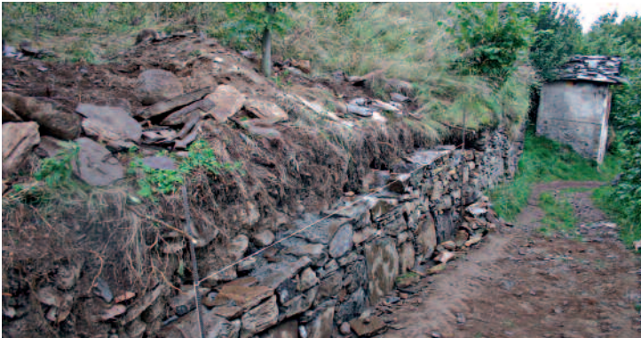
Le pietre vanno disposte in modo da formare corsi orizzontali uniformi per ripartire equamente i carichi
