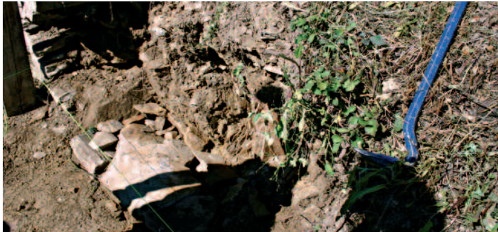
Per la realizzazione delle fondazioni le pietre di grandi dimensioni vanno collocate sul fondo; per lo spostamento di tali pietre si può utilizzare una leva (in azzurro nella foto)
