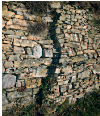
Esempi di non corretto attacco del muro recuperato al muro esistente poiché non viene mantenuto il filo verticale esterno: col tempo questo sfalsamento darà facilmente origine a cedimenti differenziali
