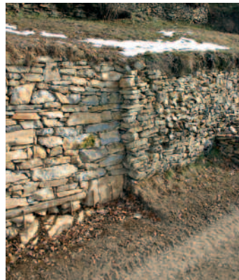
Esempi di non corretto attacco del muro recuperato al muro esistente poiché non viene mantenuto il filo verticale esterno: col tempo questo sfalsamento darà facilmente origine a cedimenti differenziali
