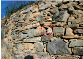
Esempio corretto di realizzazione di giunti
