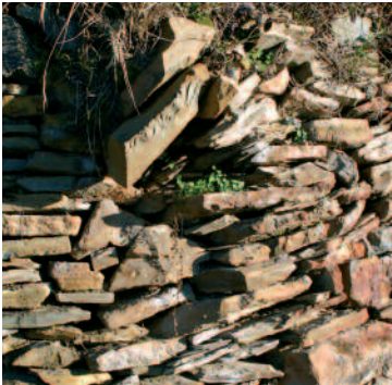
Degrado diffuso del coronamento, della base e di una parte superiore del muro
