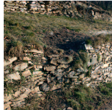
Degrado diffuso del coronamento, della base e di una parte superiore del muro
