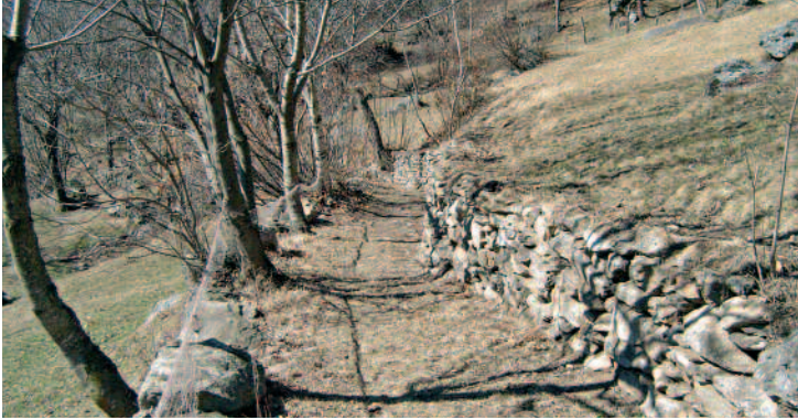
Muri di sostegno per la strada a servizio dei campi
