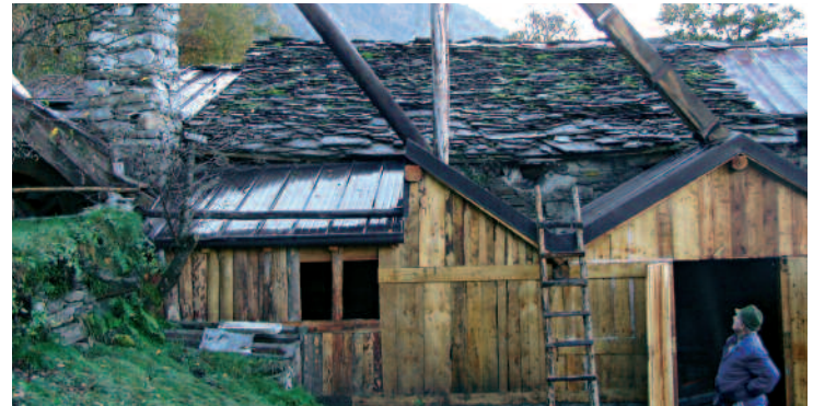
Il mulino ad acqua di Cimbergo, prima (sopra) e dopo i lavori di recupero finanziati dal Parco (sotto)
