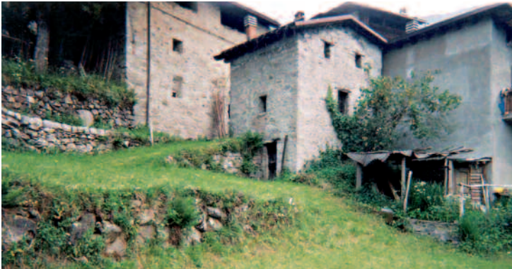
Rampe di collegamento tra terrazzi
