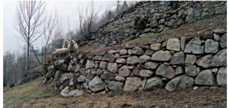
Pascolo di pecore su terrazzamenti
