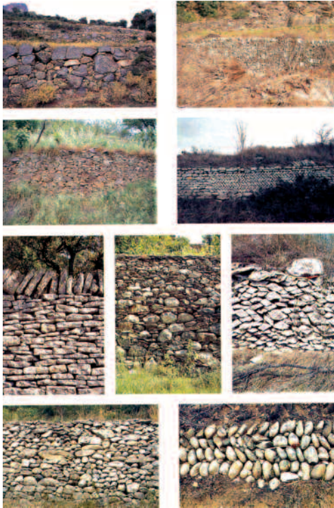
Esempi di tessiture del paramento murario
