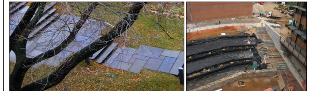
9. Percorsi su lastre lapidee di recupero 10. Zona umida per il recupero e trattamento delle acque piovane durante la costruzione
