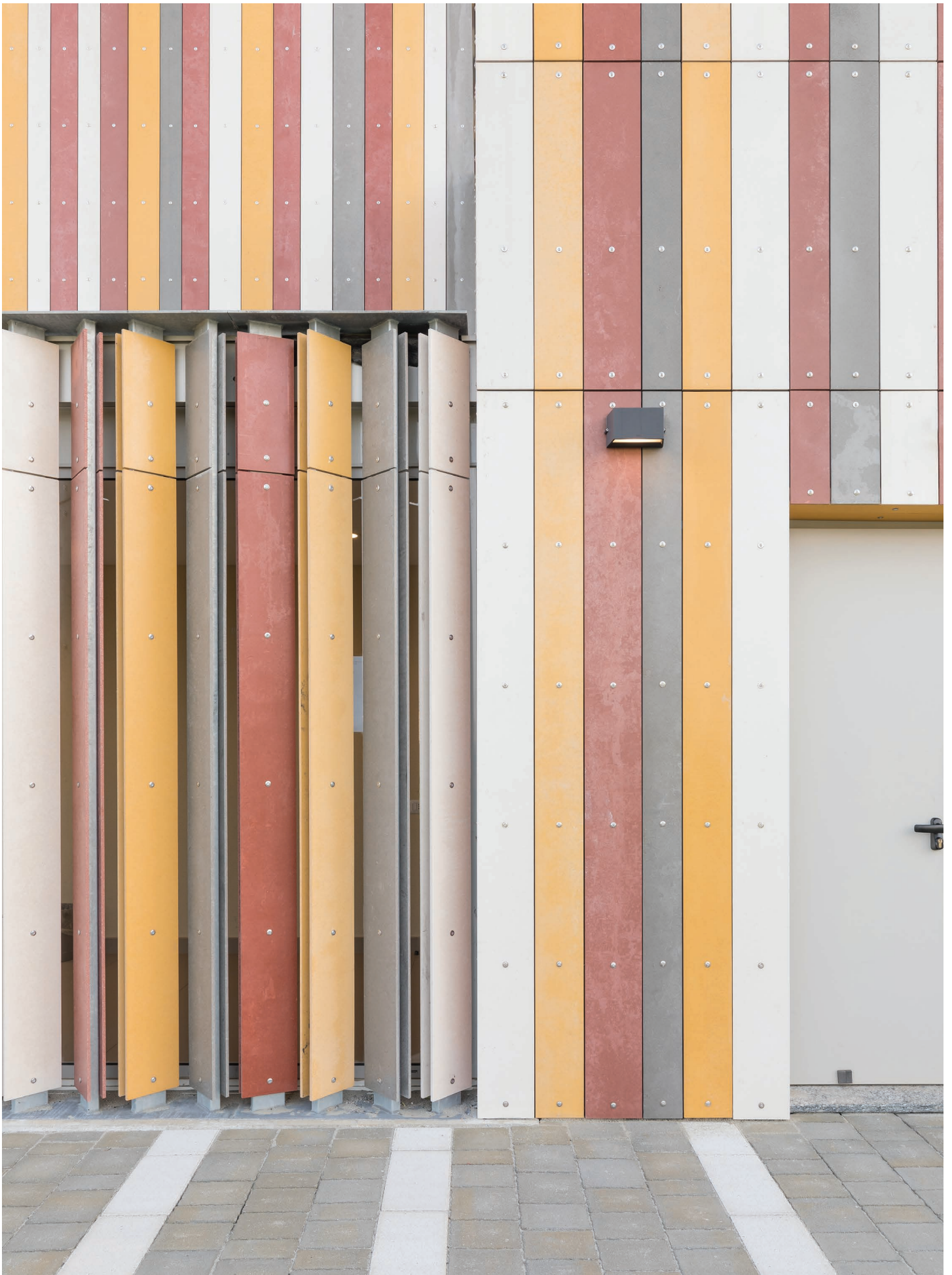
Particolare della facciata in fibrocemento a base lignea Viroc (foto Dsl)
