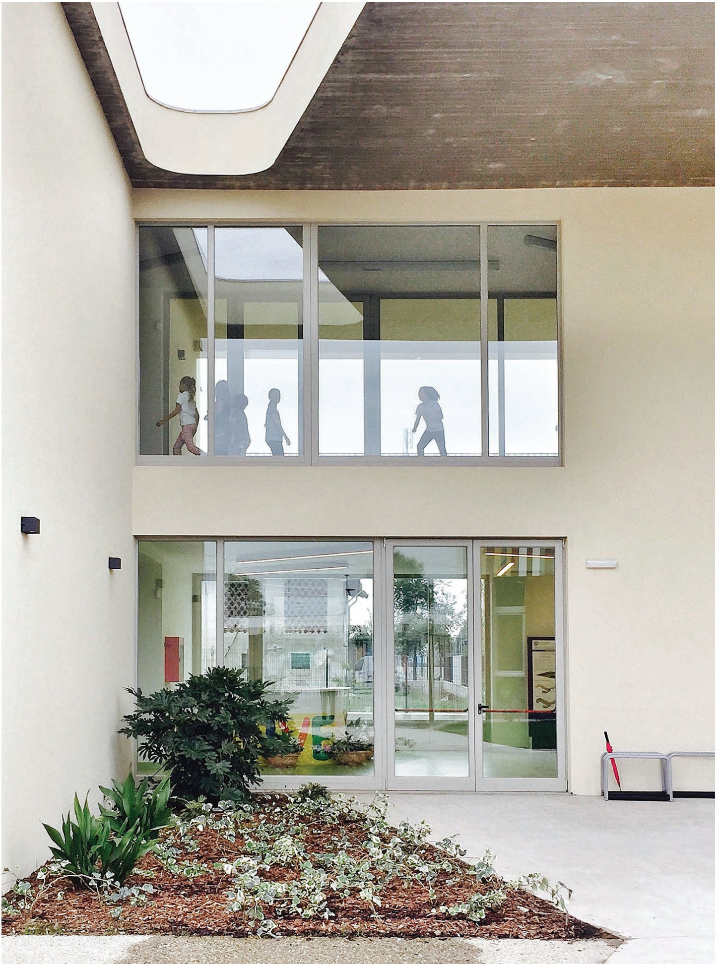
Vista della facciata principale e dell'ingresso della scuola primaria
