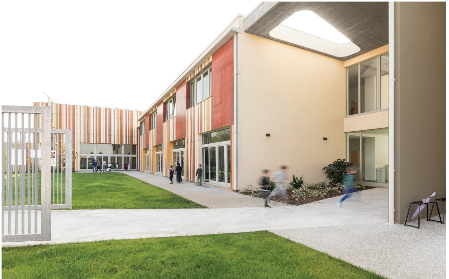
Vista della facciata principale e dell'ingresso della scuola primaria (foto DsI)
