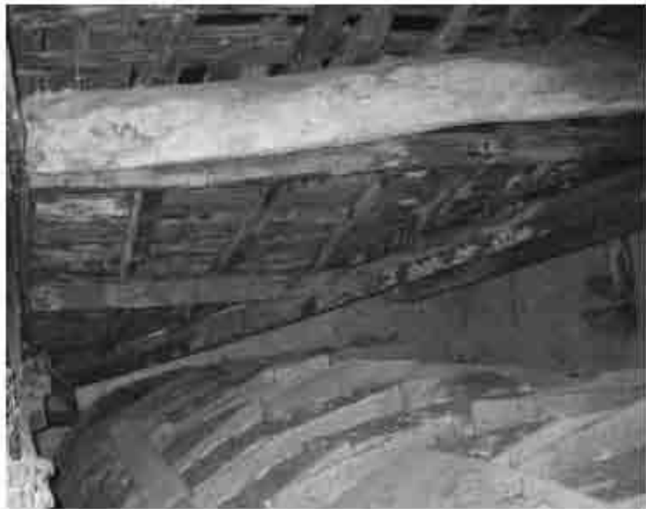
Figura 27: Saldè: Volte in cannicciata.
