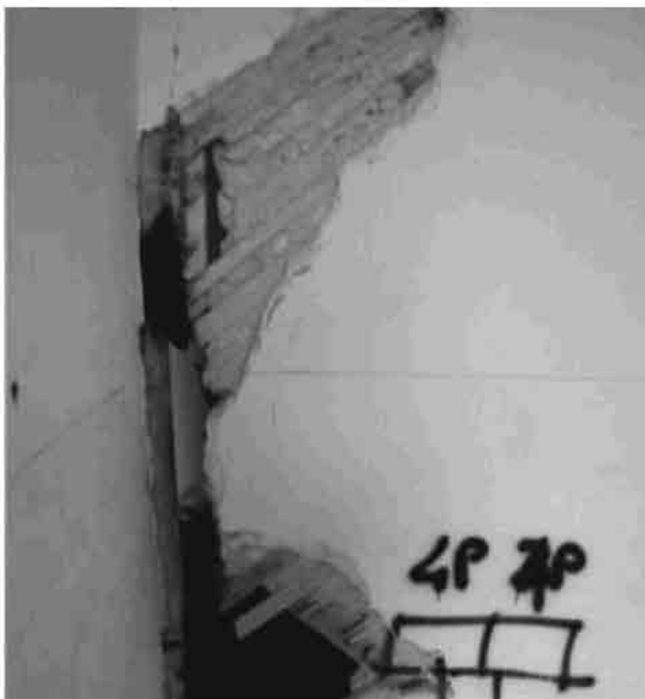
Figura 30: Salò: Parete interna in legno con listelli trasversali.
