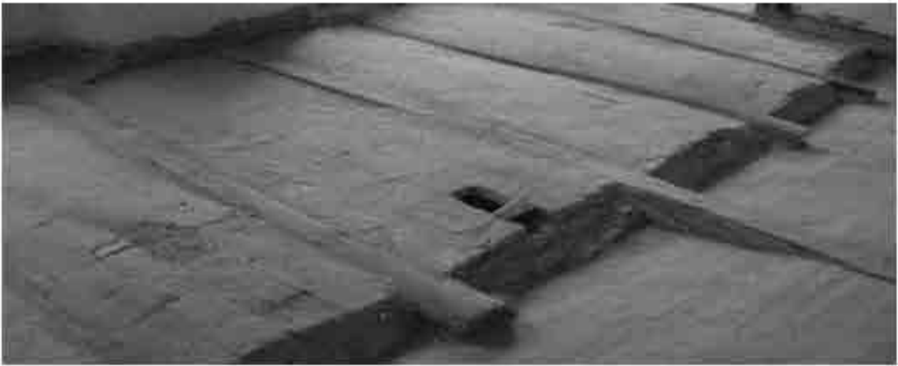
Figura 26: Saldè: Volte in legno a rastrelli.
