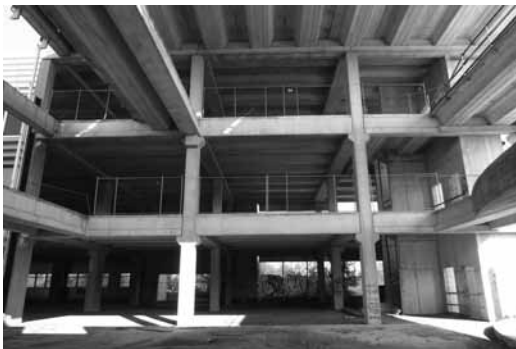
Vista dall'ingresso del primo blocco aule
