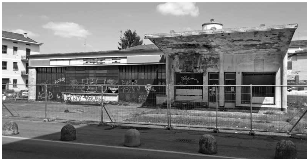
Edificio in completo abbandono in via Gramsci
