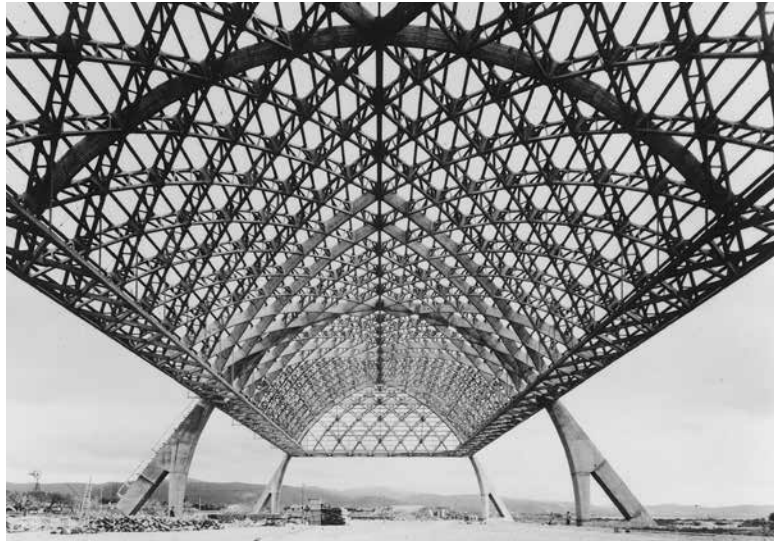
4. Aviorimessa di Orbetello, in costruzione, struttura. Studio Vasari, Roma, [1940]; CSAC, Università di Parma.
