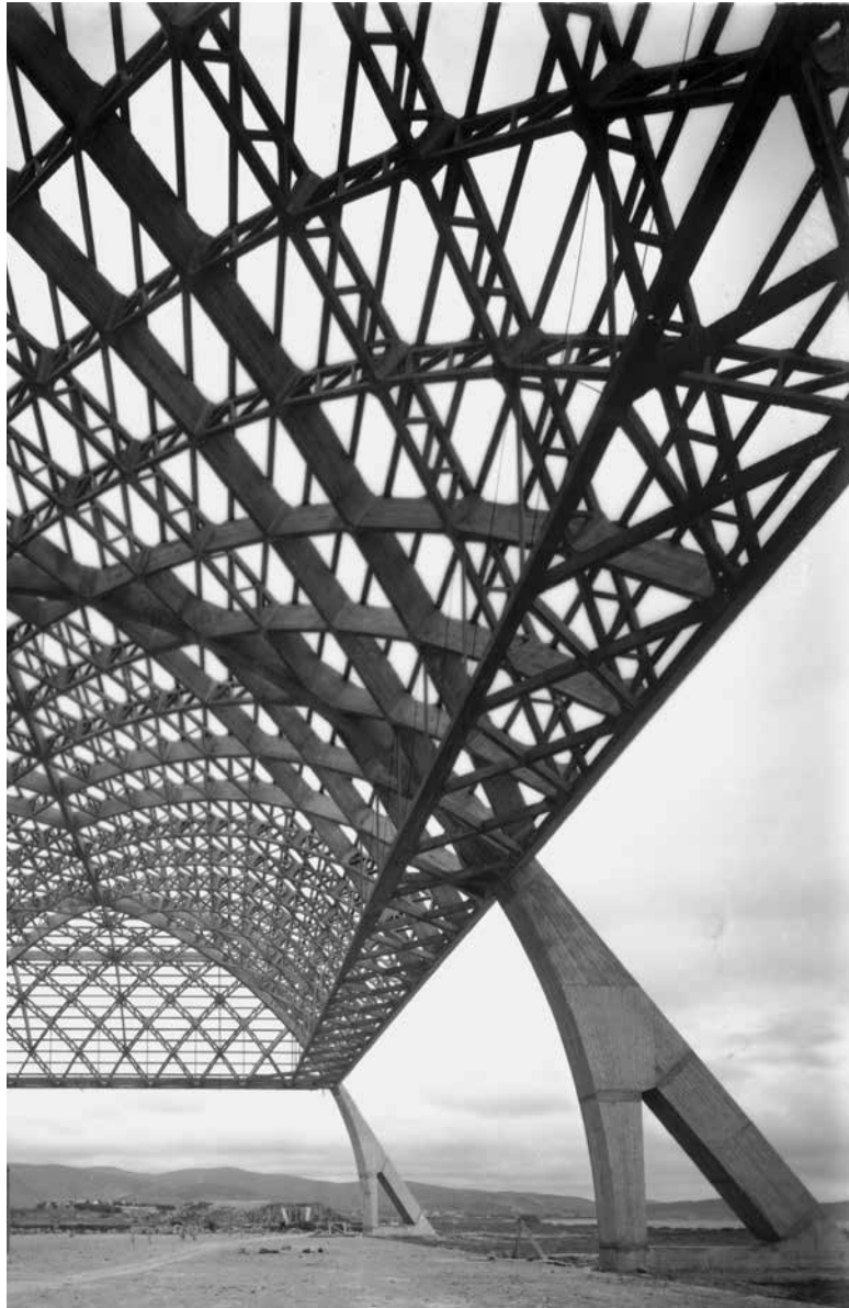
2. Aviorimessa di Orbetello, in costruzione, dettaglio della struttura. Studio Vasari, Roma, [1940]; CSAC, Università di Parma.
