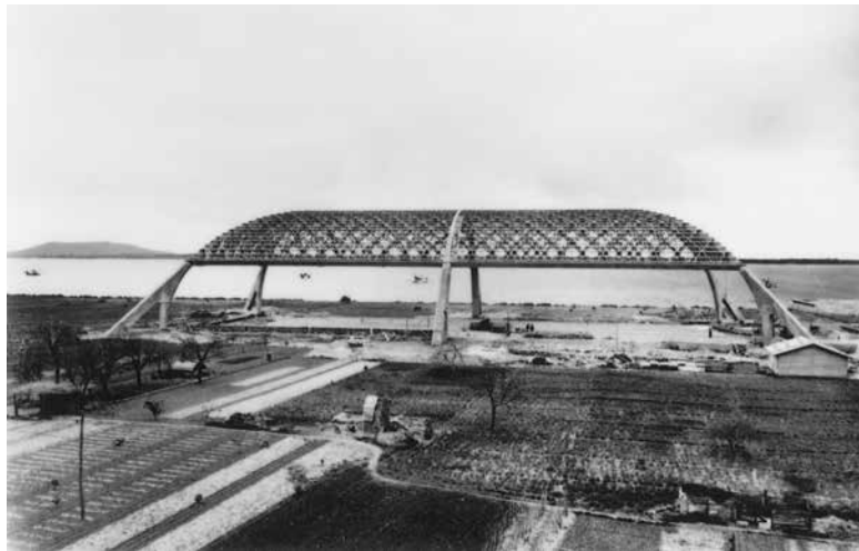
5. Aviorimessa di Orbetello, in costruzione, struttura. Studio Vasari, Roma, [1940]; CSAC, Università di Parma.
