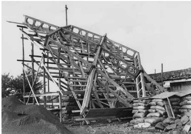
8. Impresa Nervi & Bartoli, prototipazione della struttura prefabbricata. Studio Vasari, Roma, [1939]; CSAC, Università di Parma.
